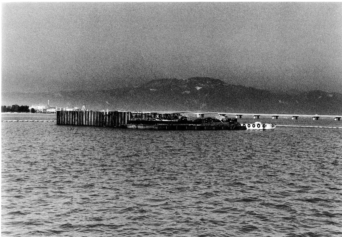
調査地遠景(南東から)
