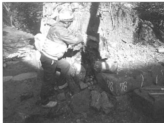
写真121 石垣117・118解体状況
