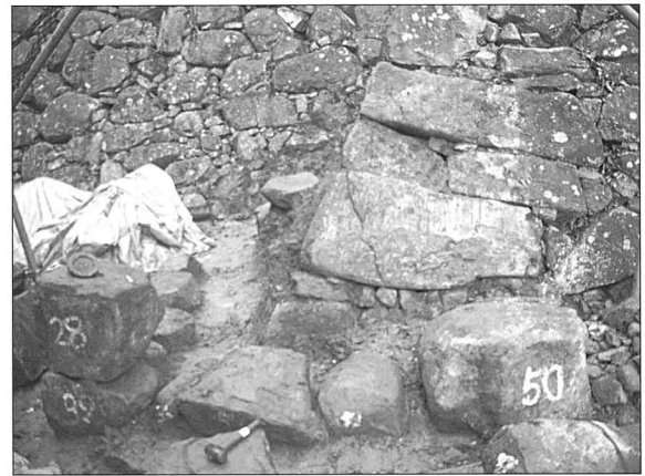
写真135 石垣No.18解体完了状況
