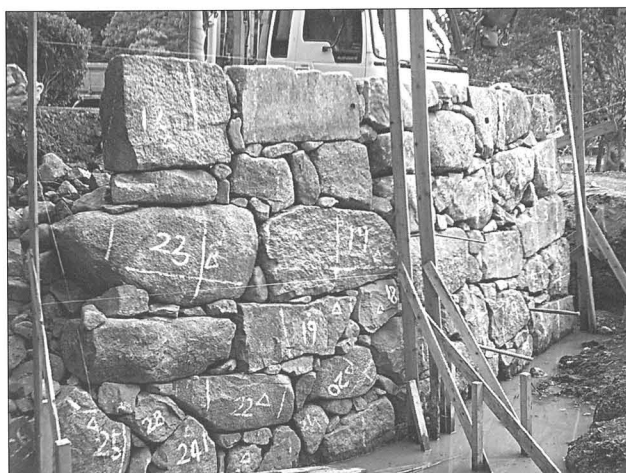
【下】写真59 石垣積直し状況（第4面）
