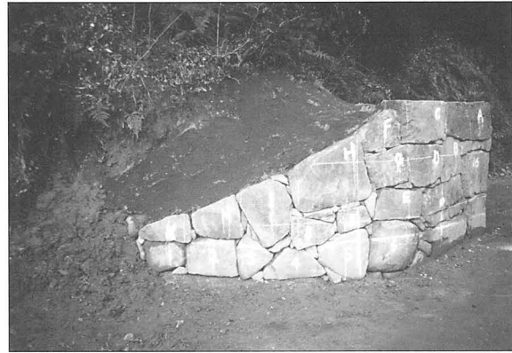
写真30 修理後 (御門石垣第1面)
