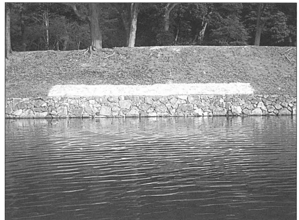
写真79 修理後（内堀沿い修理石垣No. 7）
