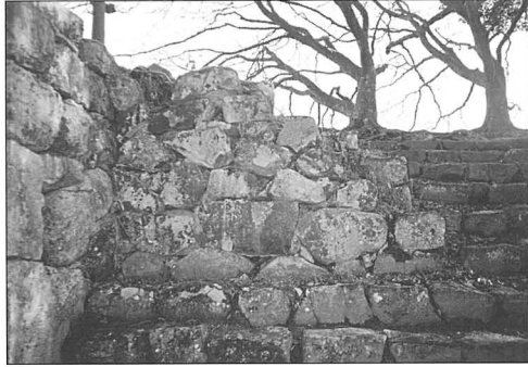
写真35 修理前（雁木石垣第5面）
