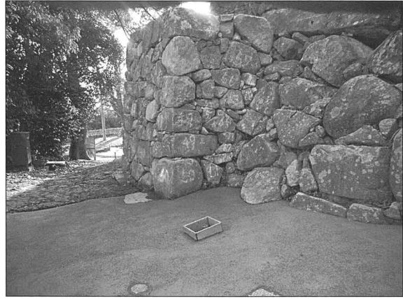
写真127 修理後 (石垣No.18-1)
