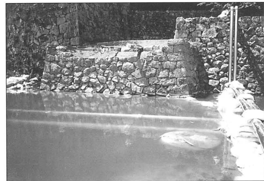
写真6 修理後（表御門橋石垣第4面）
