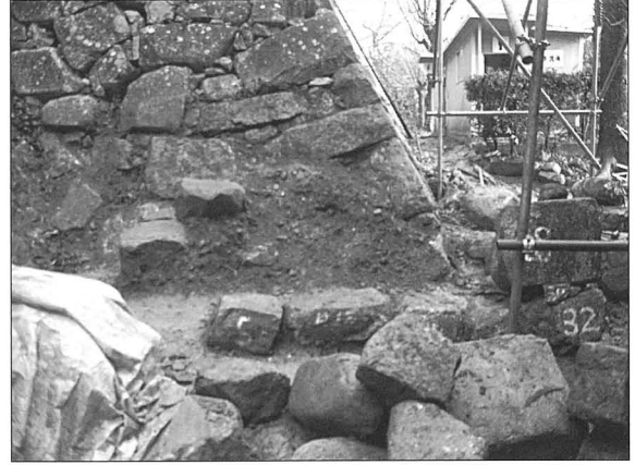
写真133 石垣No.19解体完了状況
