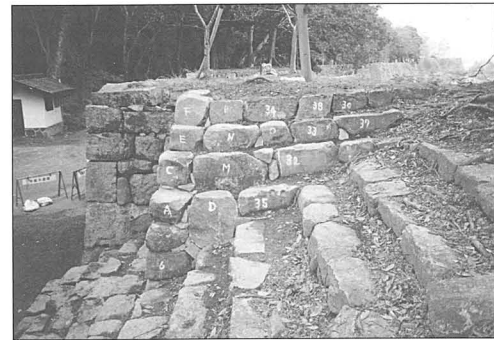
写真38 修理後（雁木石垣第6面）
