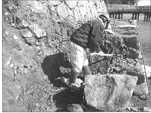
写真101 石垣解体状況 2 (北から撮影)
