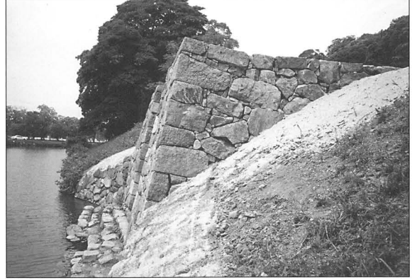
写真16 修理後 (米蔵水門石垣第3面)
