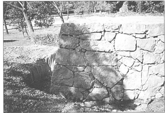
写真44 修理後（第2面南側）
