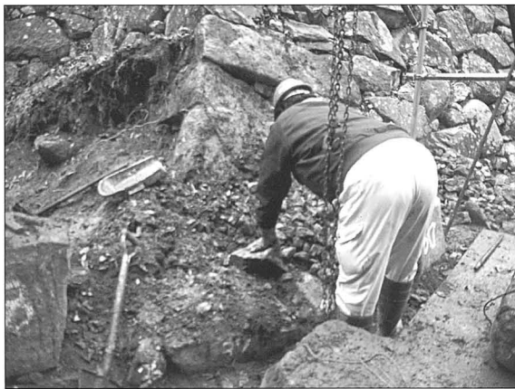
写真134 石垣No.18解体状況
