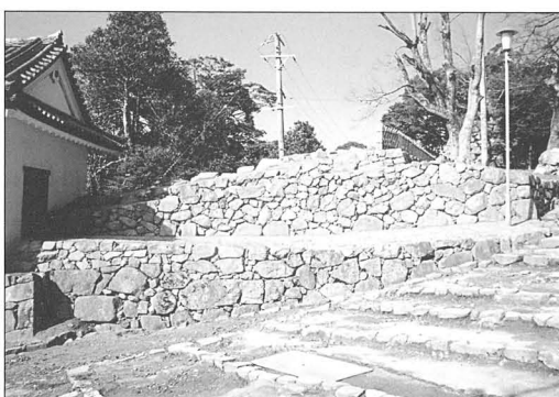
写真63 修理後（正面から撮影）
