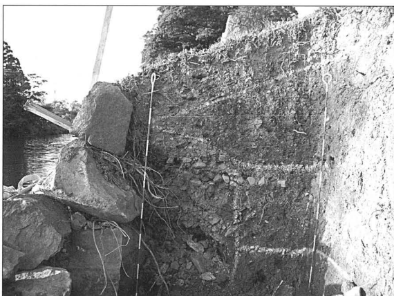
写真97 石垣No.14北壁断面
