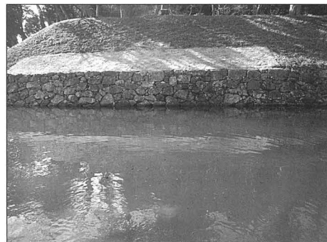
写真71 修理後（内堀沿い修理石垣No.3）
