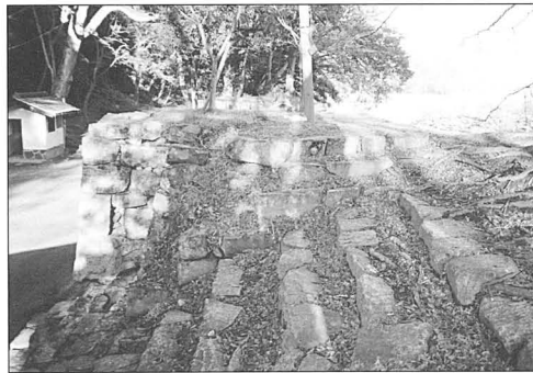
写真37 修理前（雁木石垣第6面）
