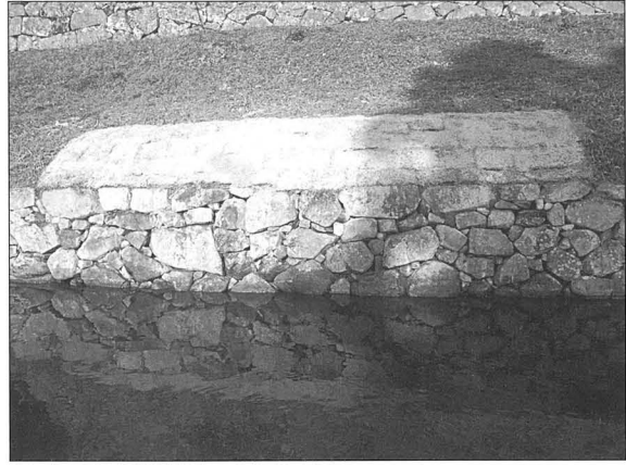
写真73 修理後（内堀沿い修理石垣No. 4）
