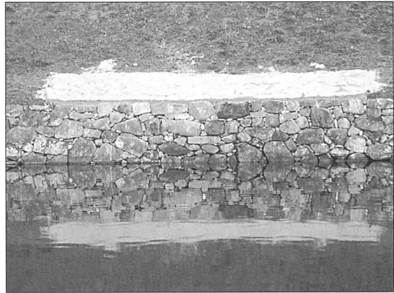
写真75 修理後（内堀沿い修理石垣No. 5）
