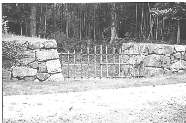
【下】写真61 石垣保存修理完了状況（正面から撮影）
