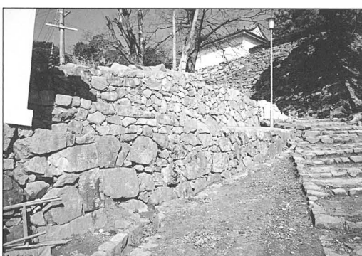
写真65 修理後（東から撮影）
