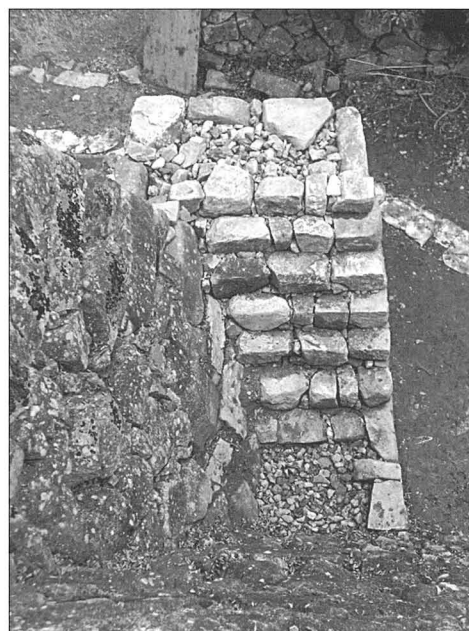
写真125 階段施設復元整備状況
