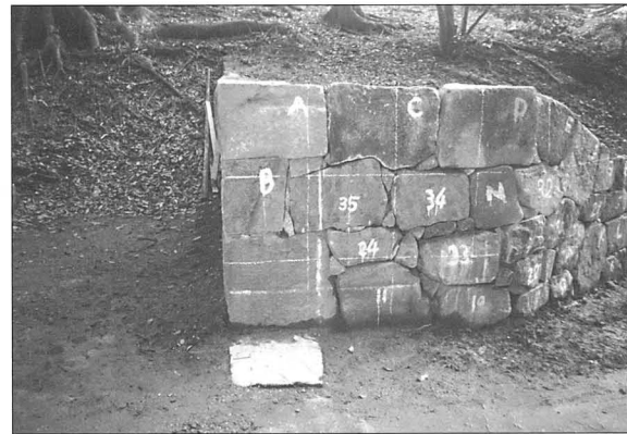
写真32 修理後 (御門石垣第3面)
