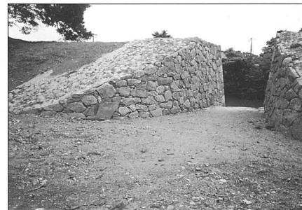
写真12 修理後(米蔵水門石垣第5面)
