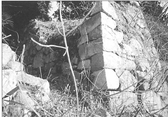
写真19 修理前 (米蔵水門石垣第1・5面)
