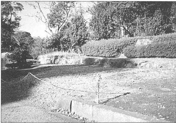
写真52 修理前（第3面、南から撮影）
