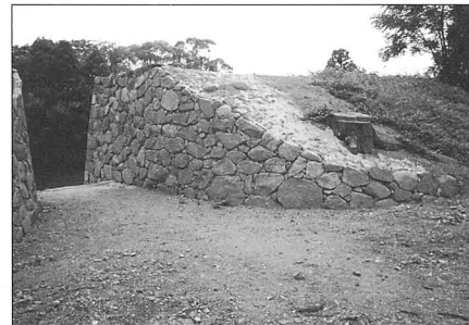
写真10 修理後(米蔵水門石垣第6面)
