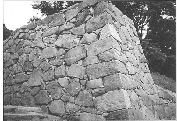
写真20 修理後 (米蔵水門石垣第1・5面)
