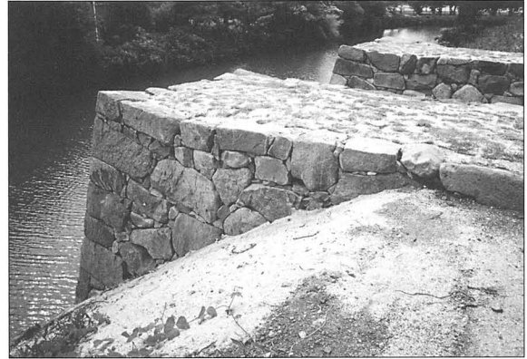
写真18 修理後 (米蔵水門石垣第3面)
