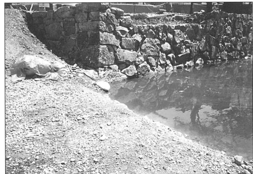
写真4 修理後（表御門橋石垣第1・2面）
