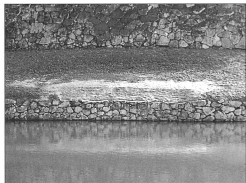
写真90 修理後（内堀沿い修理石垣No.12）
