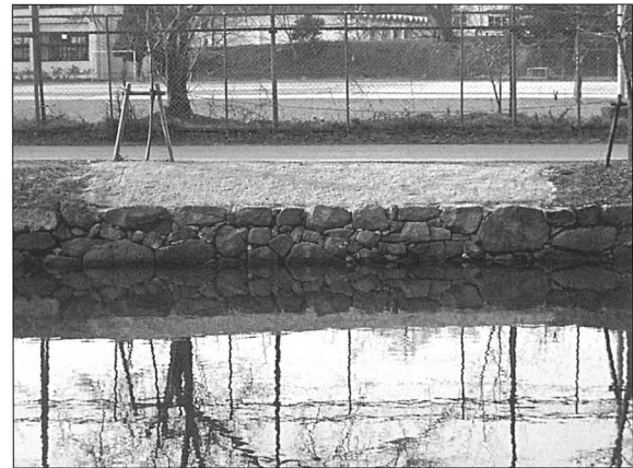
写真87 修理後（内堀沿い修理石垣No.11）
