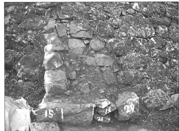
写真122 石垣102解体状況
