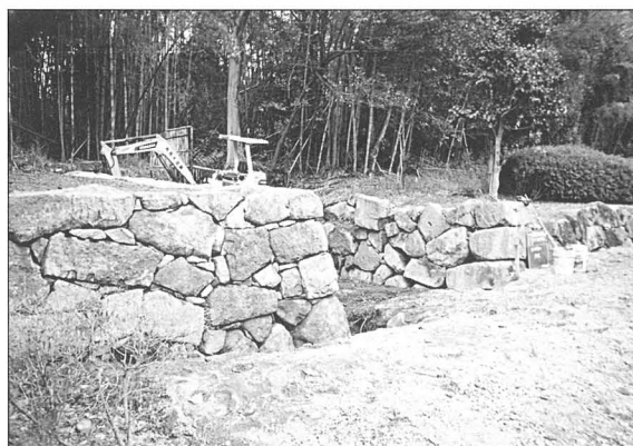
写真40 修理後（正面から撮影）
