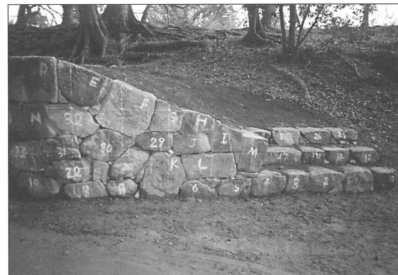
写真34 修理後 (御門石垣第3面)
