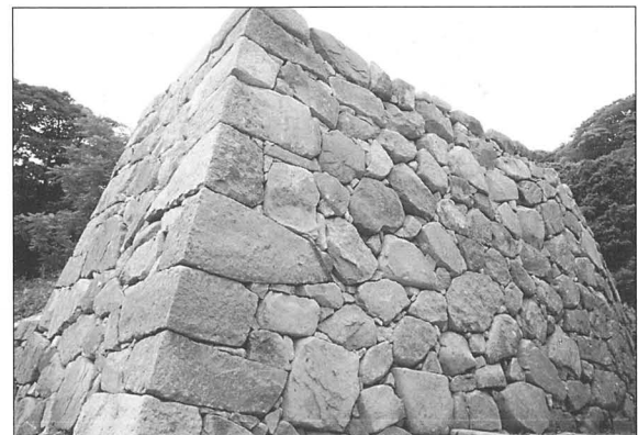
写真22 修理後 (米蔵水門石垣第2・6面)
