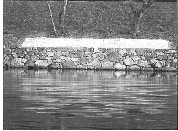
写真85 修理後（内堀沿い修理石垣No.10）
