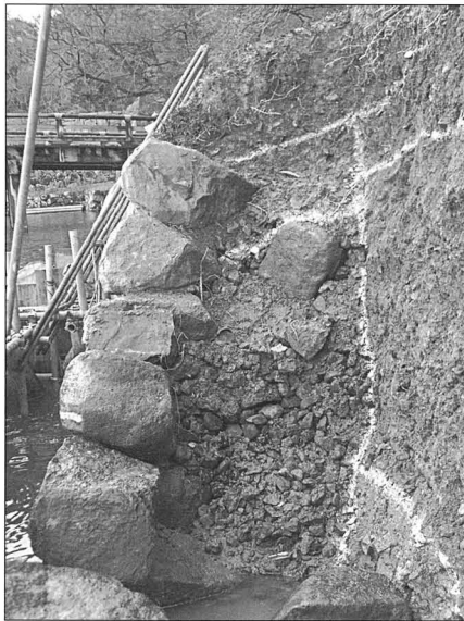
写真95 石垣No.12北壁断面
