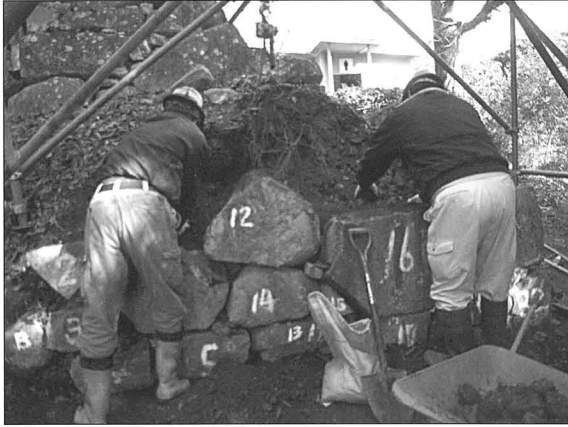
写真132 石垣No.19解体状況
