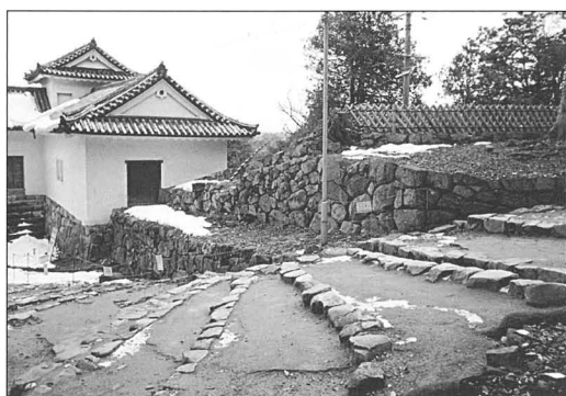
写真66 修理前（北から撮影）
