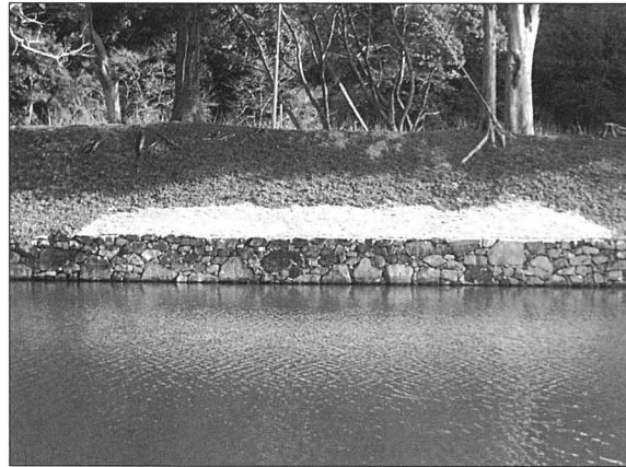
写真92 修理後 (内堀沿い修理石垣No.13)
