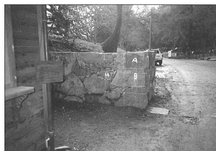
写真26 修理後(御門石垣第4面)
