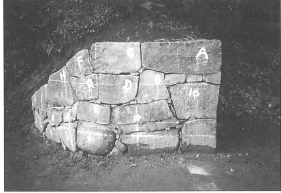
写真28 修理後 (御門石垣第1面)
