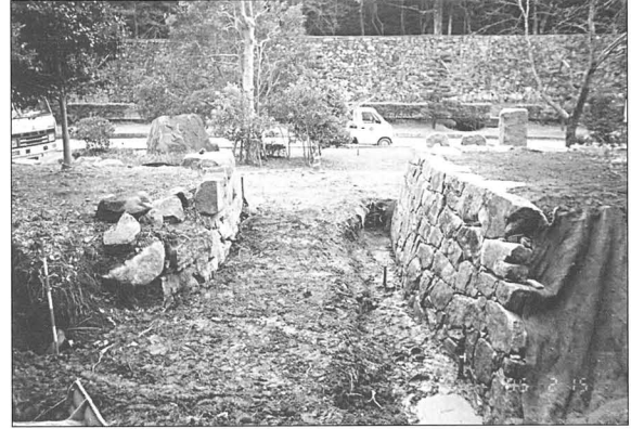
写真42 修理後（背面から撮影）
