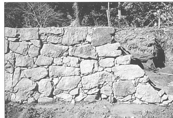
写真48 修理後（第2面北側）
