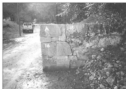
写真24 修理後(御門石垣第2面)
