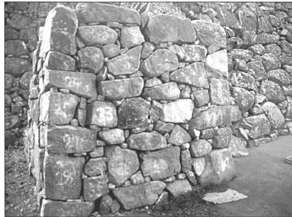
写真129 修理後 (石垣No.18)
