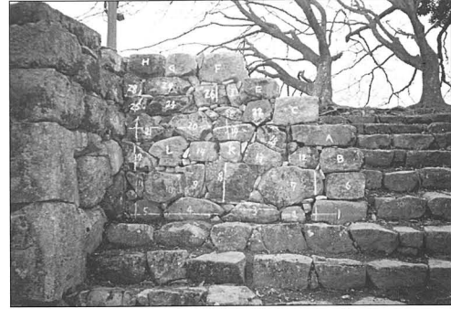
写真36 修理後（雁木石垣第5面）
