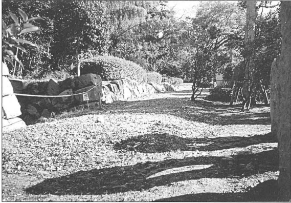
写真50 修理前（第3面、西から撮影）
