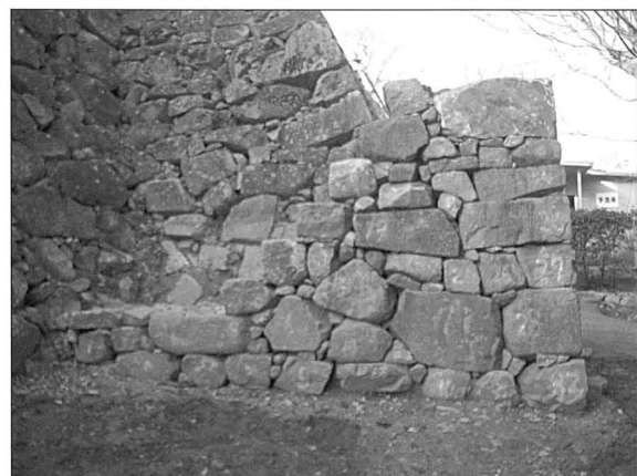
写真131 修理後 (石垣No.19)
