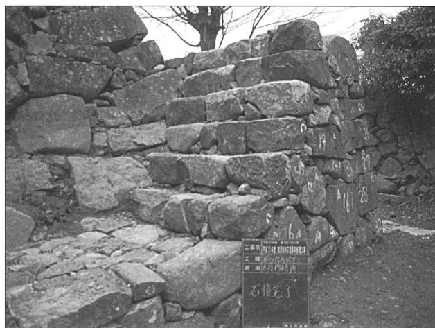
写真124 石垣No.19修理完了状況
