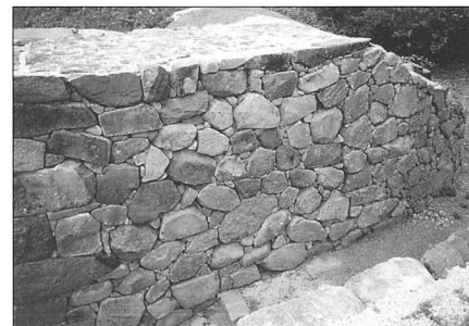
写真14 修理後(米蔵水門石垣第6面)
