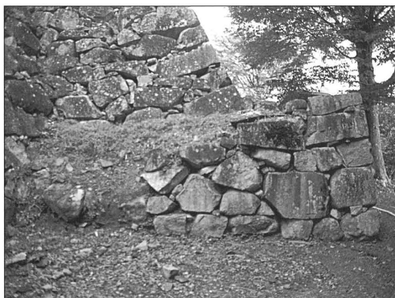
写真130 修理前 (石垣No.19)
