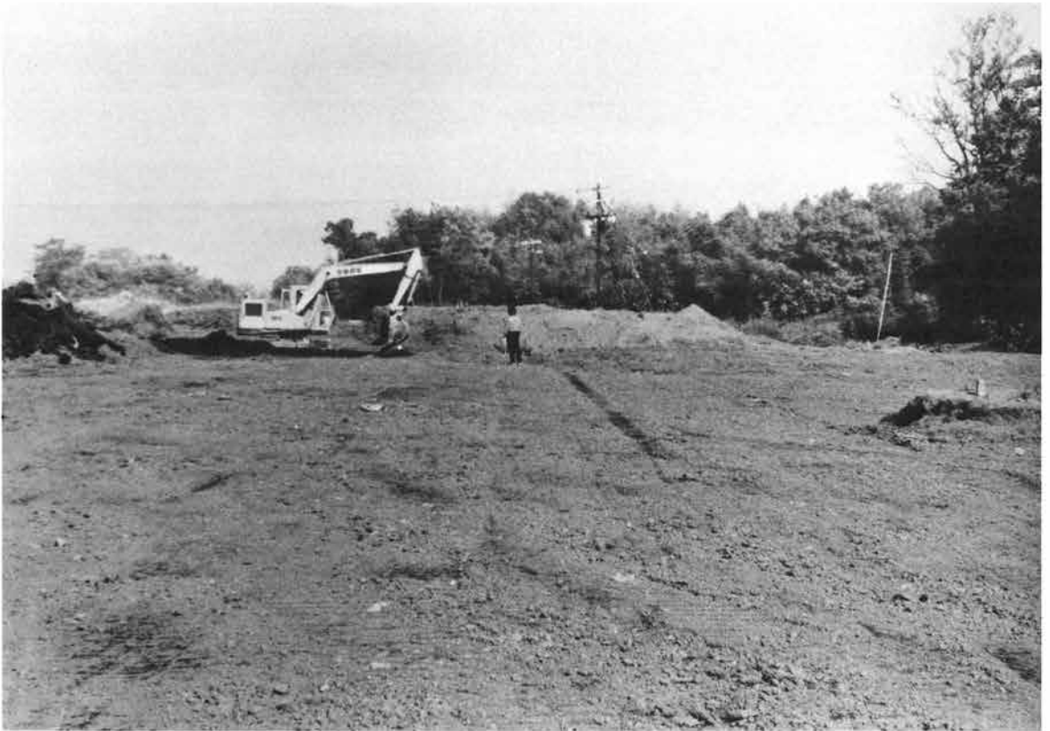
調査終了後埋めもとし作業
