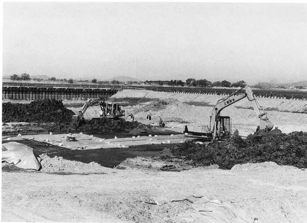
第3トレンチ表土掘削作業（西南より）
