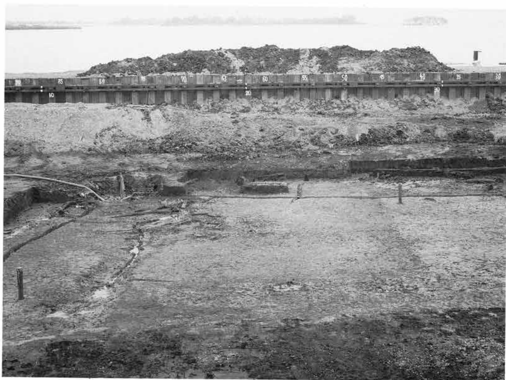
中層部完了近景
