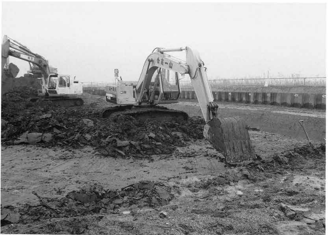
調査風景（表土掘削）
