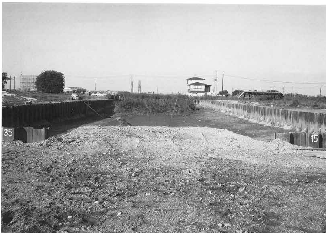
調査前近景 (南西より)
