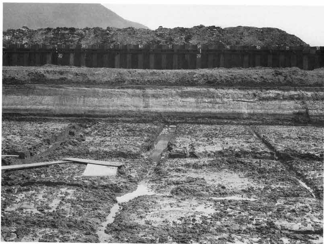
下層部完了近景
