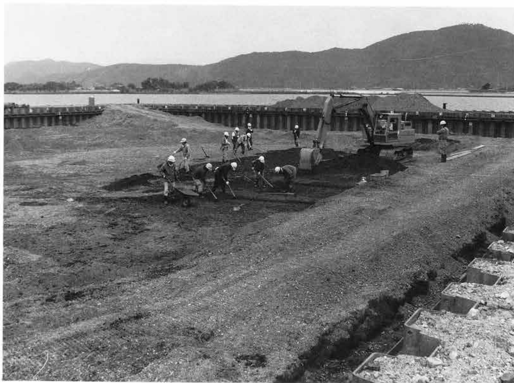
上層部掘削作業風景
