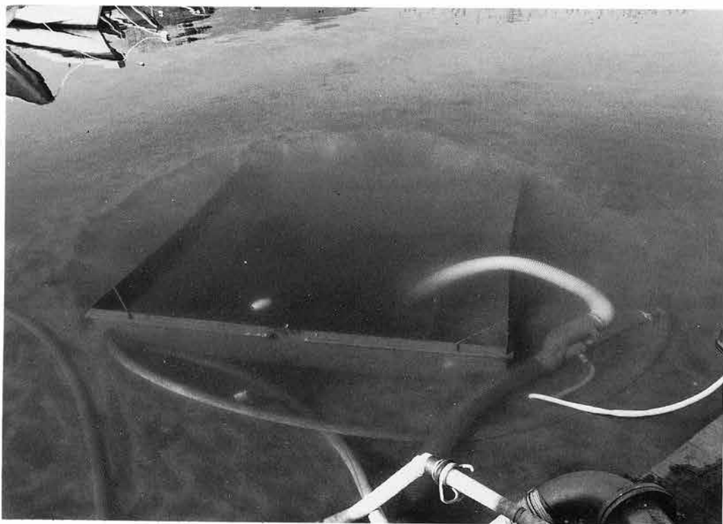
P-1 掘削状況
