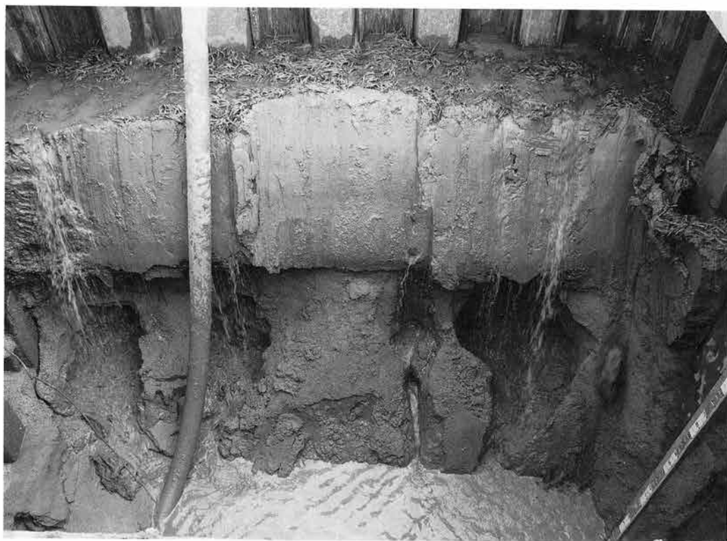
トレンチ断面状況
