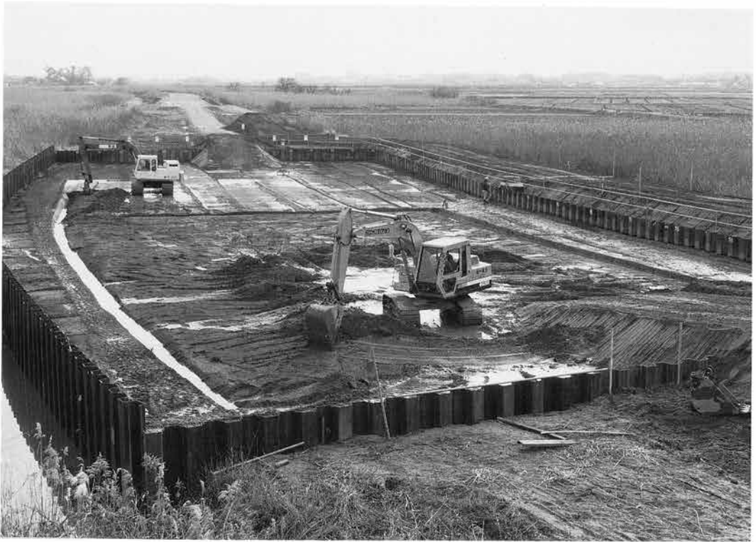
調査地遠景（西より）
