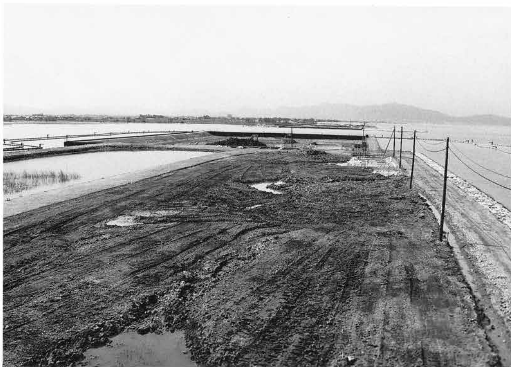
調査区遠景 (北より)
