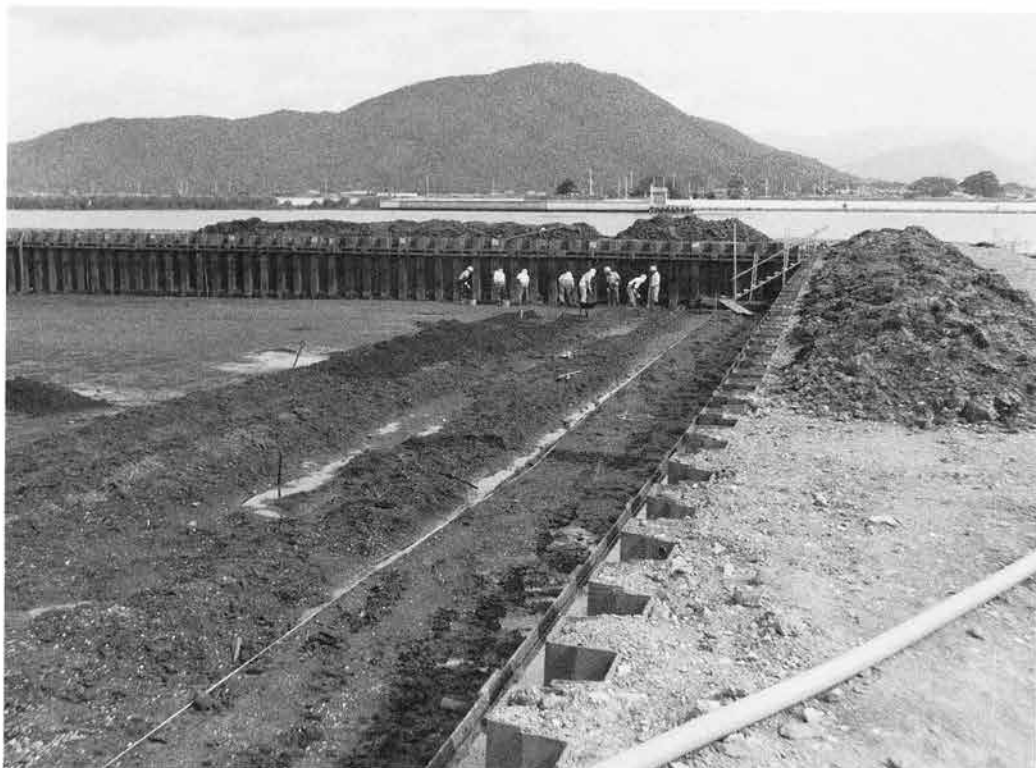
上層部掘削作業風景
