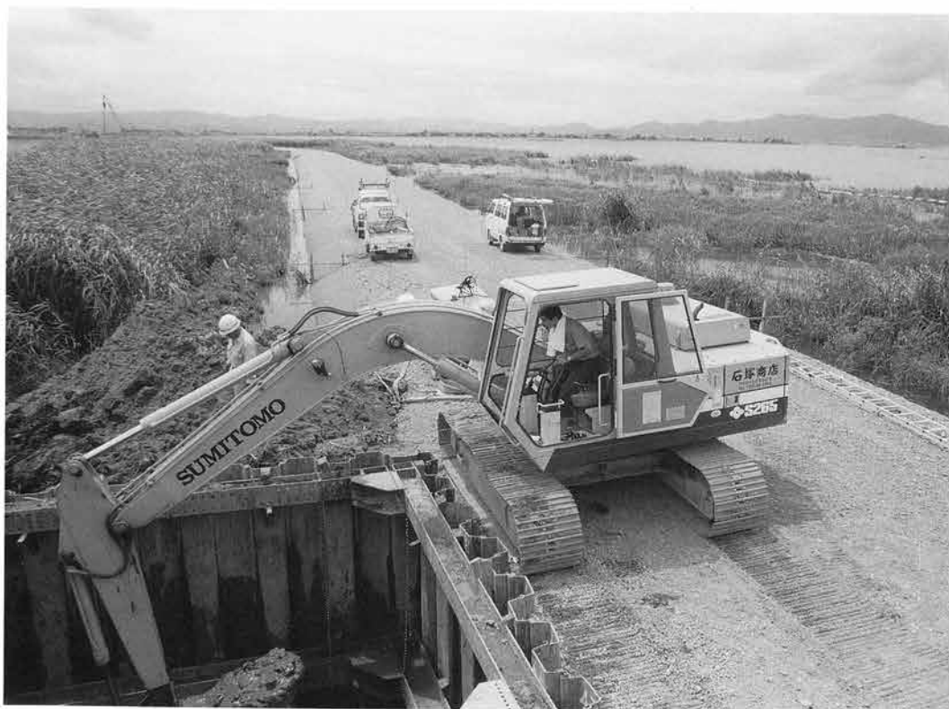
調査区全景及び調査状況（北から）
