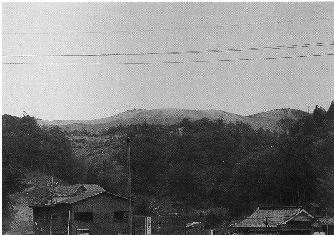
1. 調査地調査後の遠景(南から)
