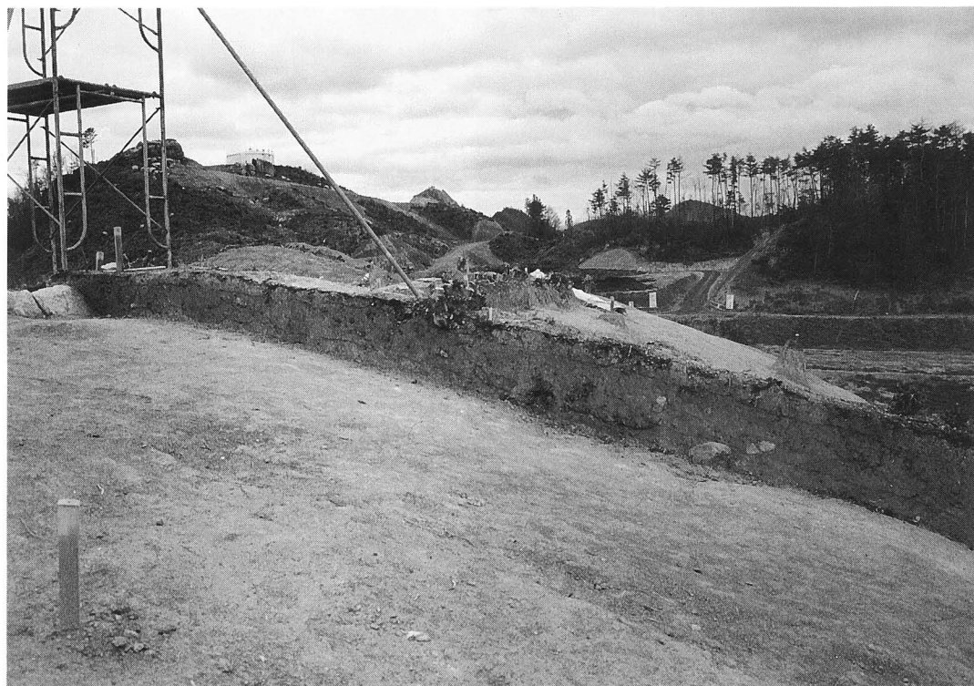
1. 31号墳南側土層(西から)
