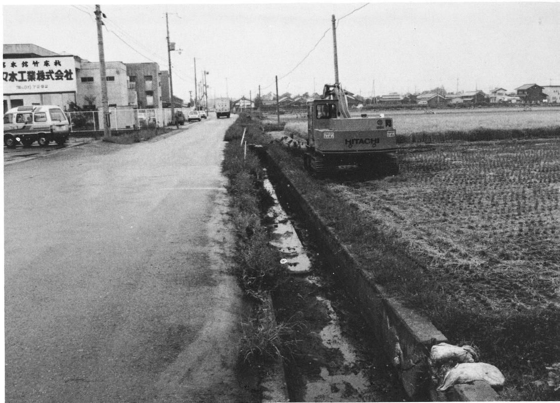
調査前現地全景（東から）
