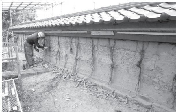
第2332図 土壁工 南北土塀西面 瓦端部のハツリ
