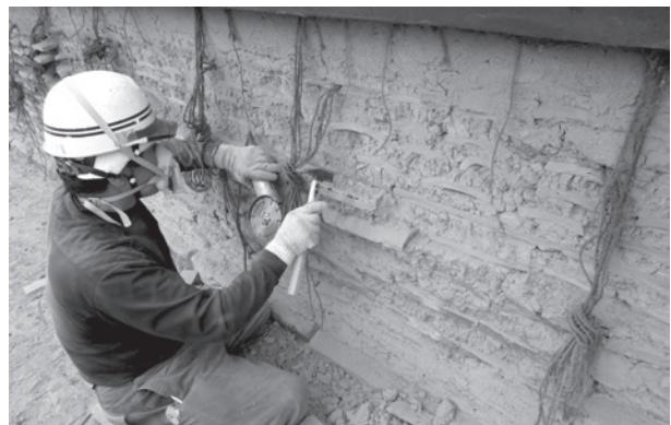
第2333図 土壁工 南北土塀西面 瓦端部のハツリ
