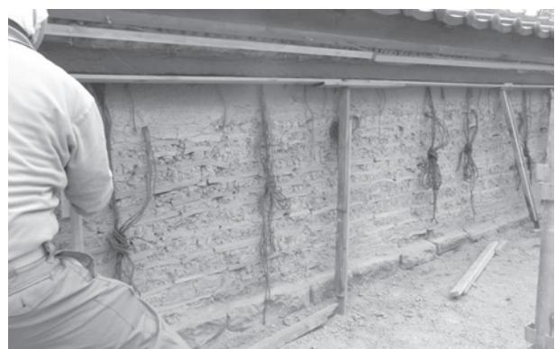
第2319図 土壁工 縄の設置
