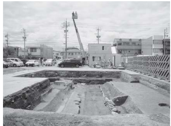
写真8 高所作業車による写真撮影
