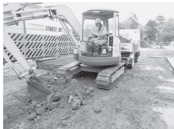
写真2 重機による表土掘削状況
