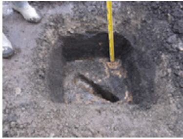
写真93 3Tピット断面 (S→)
