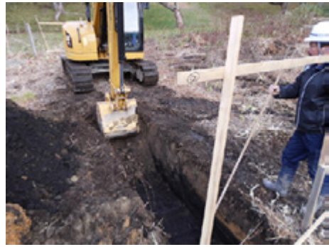
写真127 トレンチ掘削状況 (SW→)
