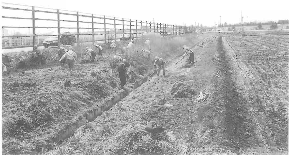
B区調査前(北から)
