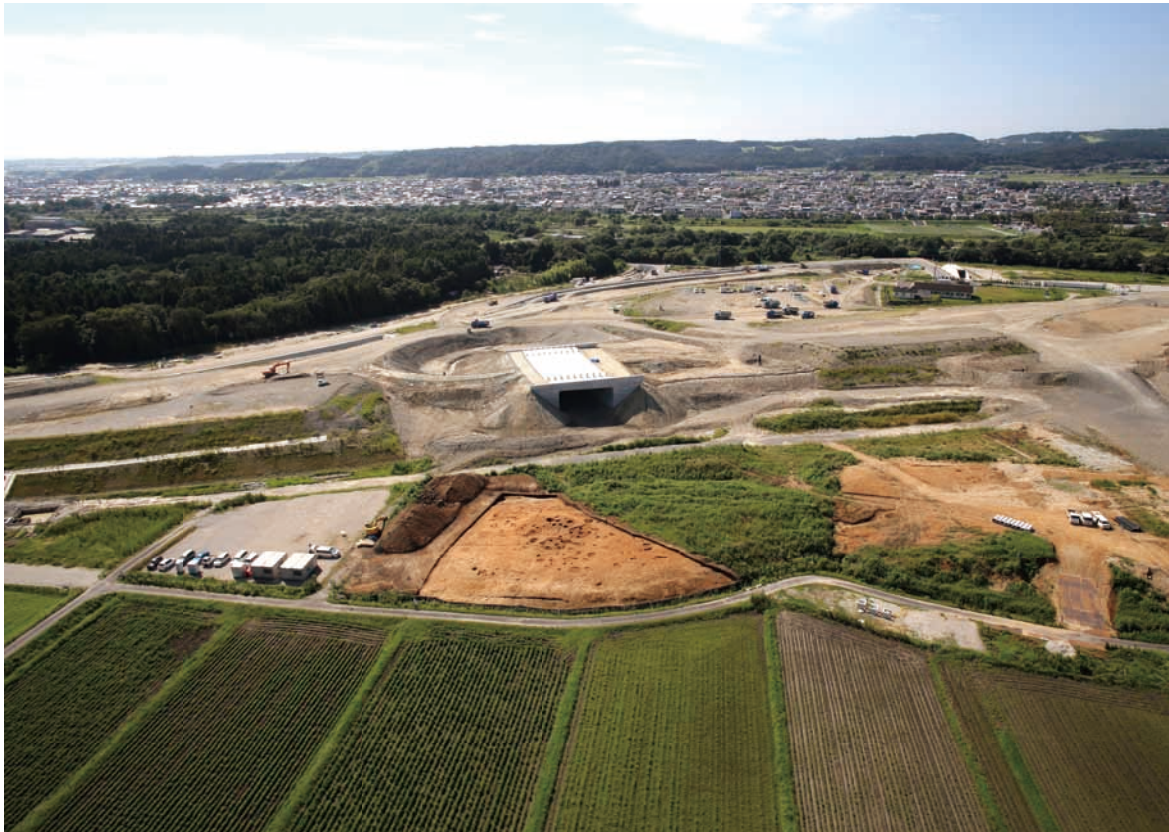
写真8 調査区全景（北上空から）
