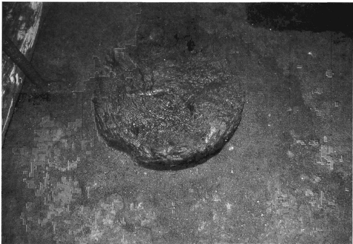
写真3 No.8 橋脚周辺の液状化1（砂の吹き出し状況）
