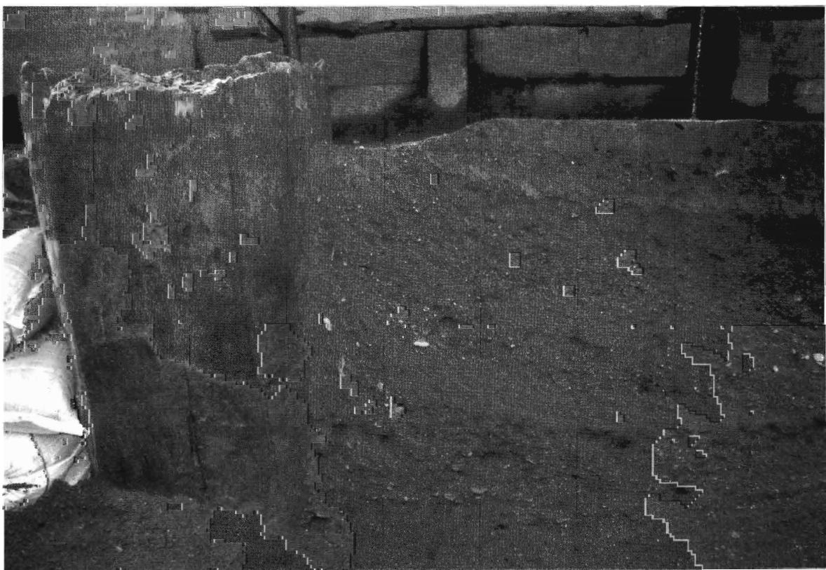
写真4 No.8 橋脚周辺の液状化2（砂の吹き出し状況）
