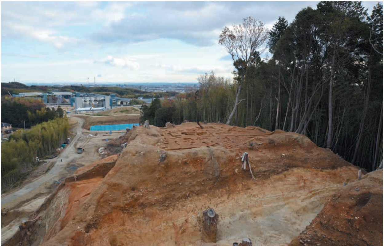
写真9 西からみた曲輪2全景
