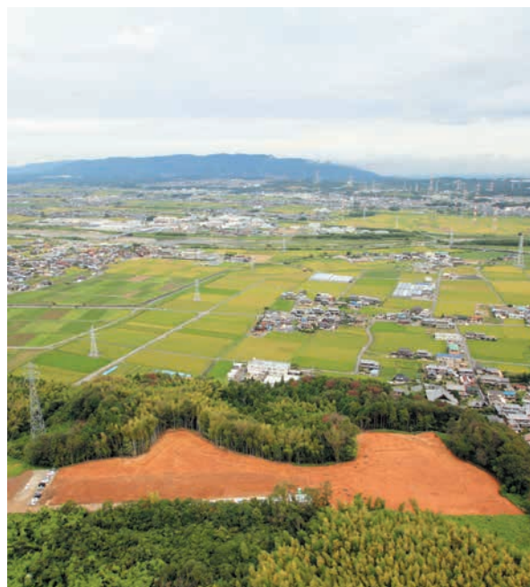
写真30 調査区全景 (南上空から)
