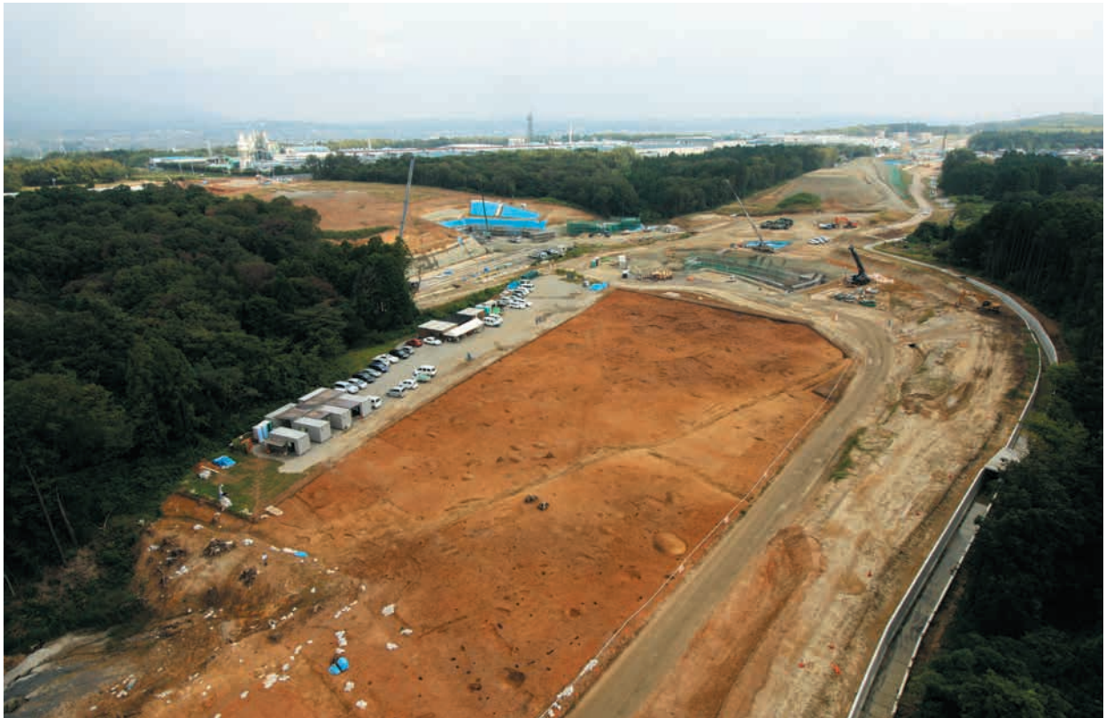
写真39 調査区全景（南西から）
