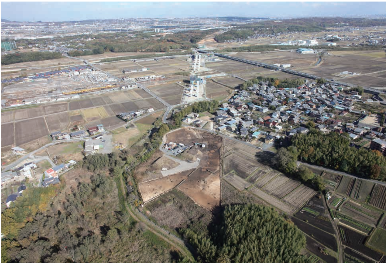
写真98 調査区全景（南西より）
