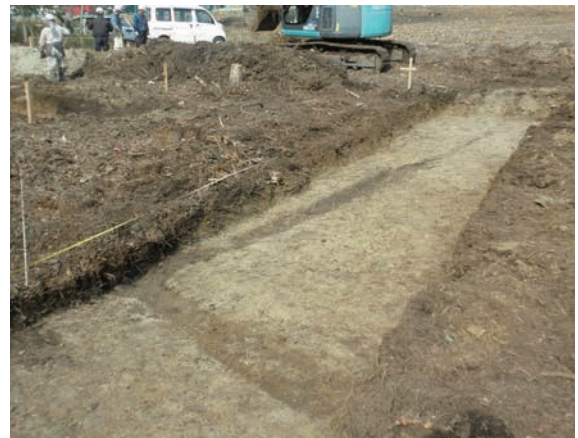
写真112 T2（南東から）
