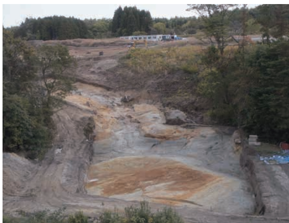
写真64 ②区完掘全景(北から)
