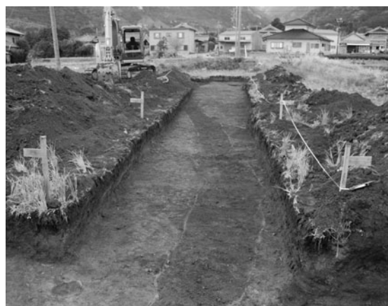
写真29 トレンチ17（東から）
