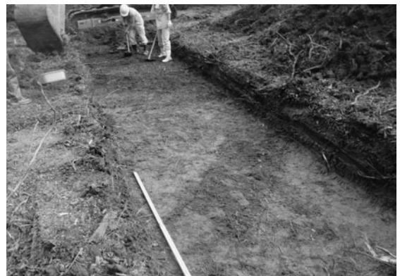
写真16 トレンチ4（北から）
