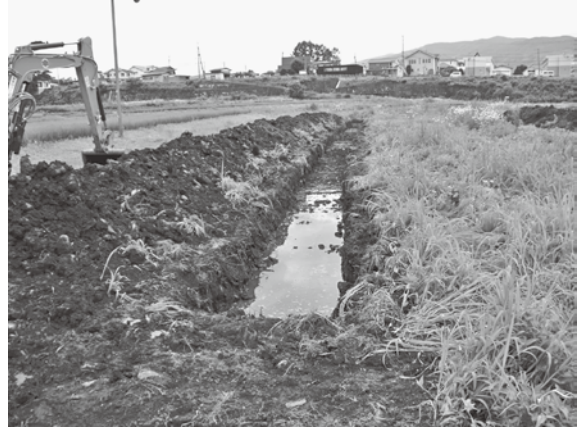
図版 12 西区 4 区完掘状況 (南から)
