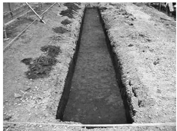
図版 2 1 区完掘状況(南東から)
