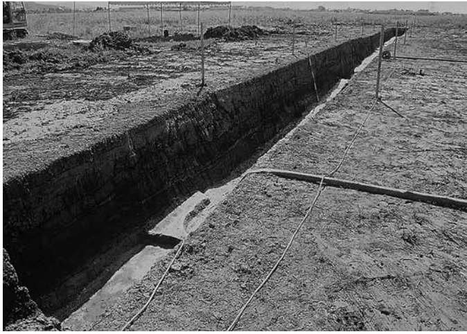
SD5・河川6 断面(東から)
