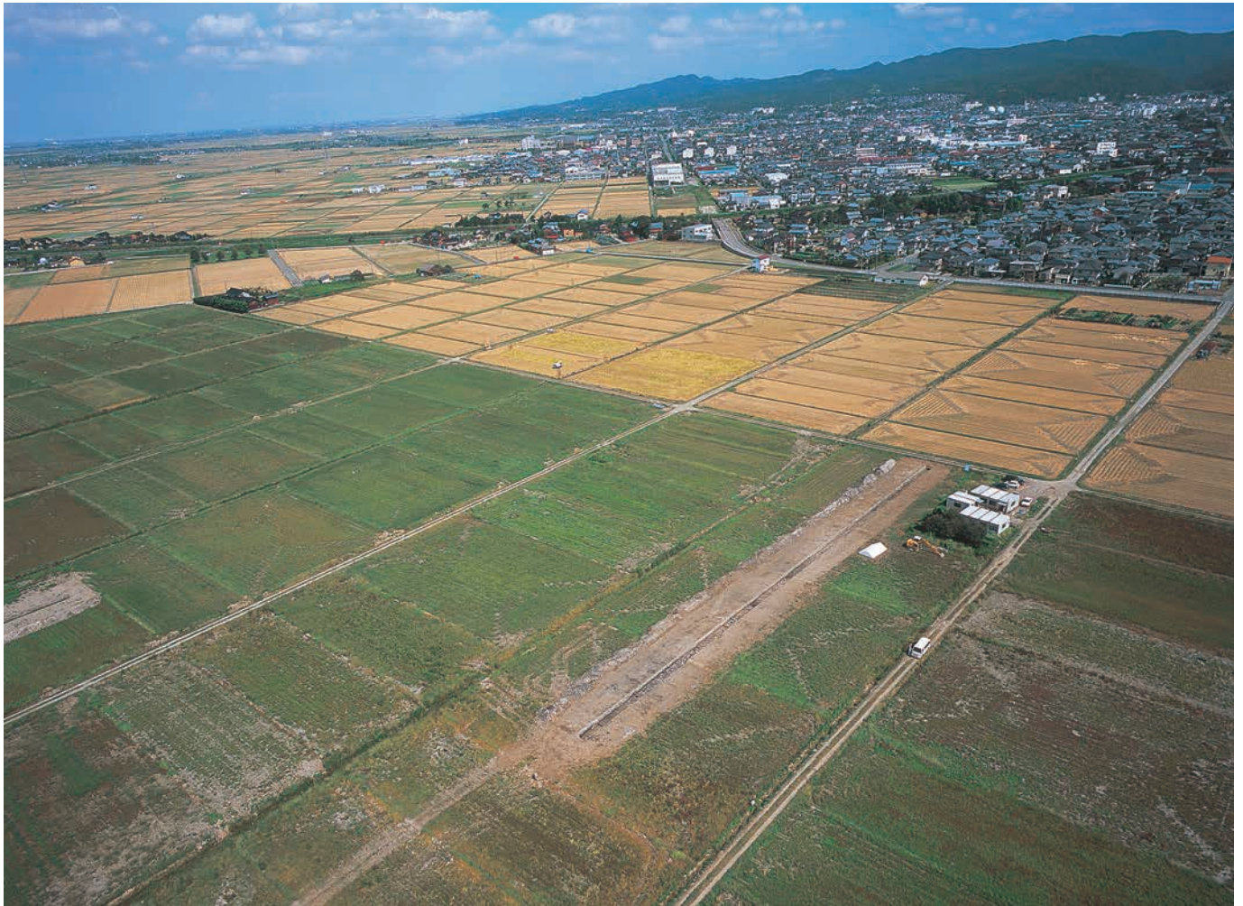
調査区 全景 空中写真 (南西から)
