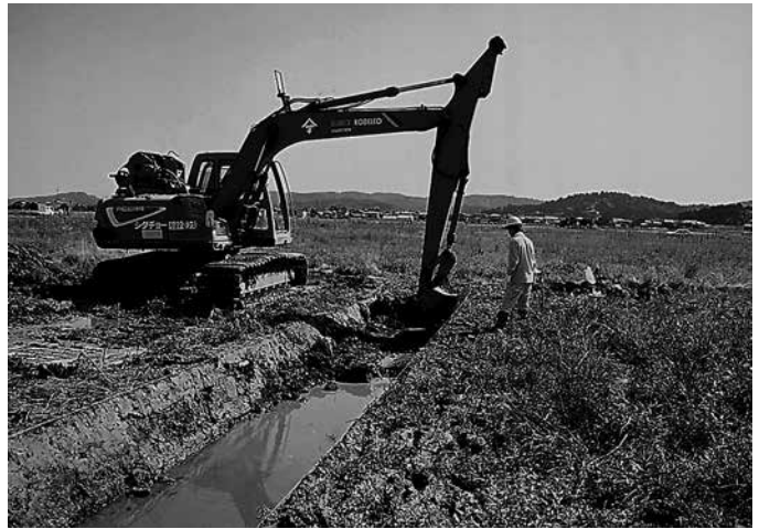
B区 表土掘削作業（西から）
