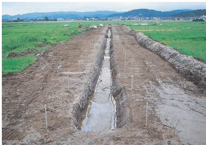
A区 全景（西から）
