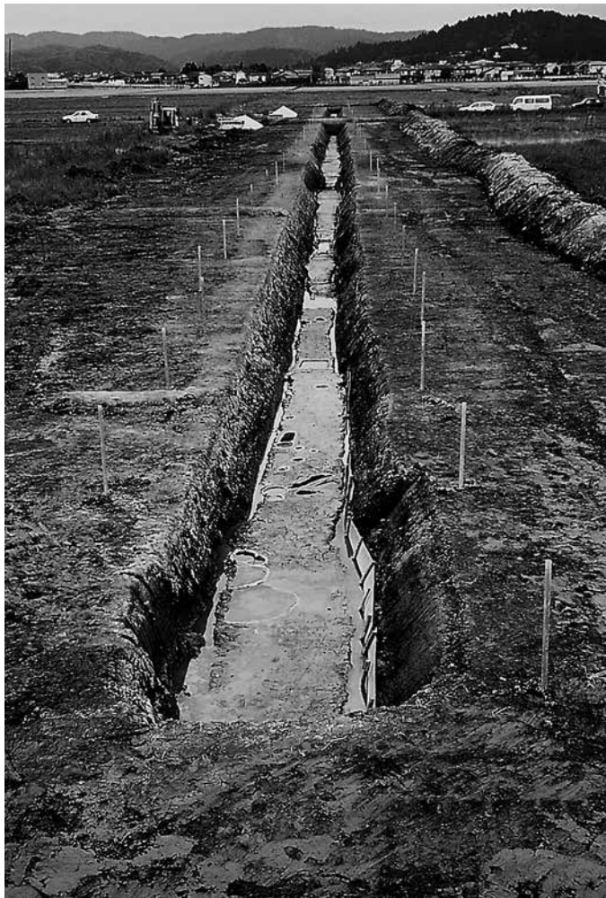
A区 全景 (西から)
