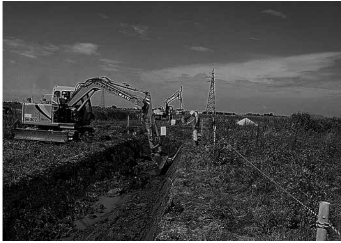
A区 表土掘削作業（東から）
