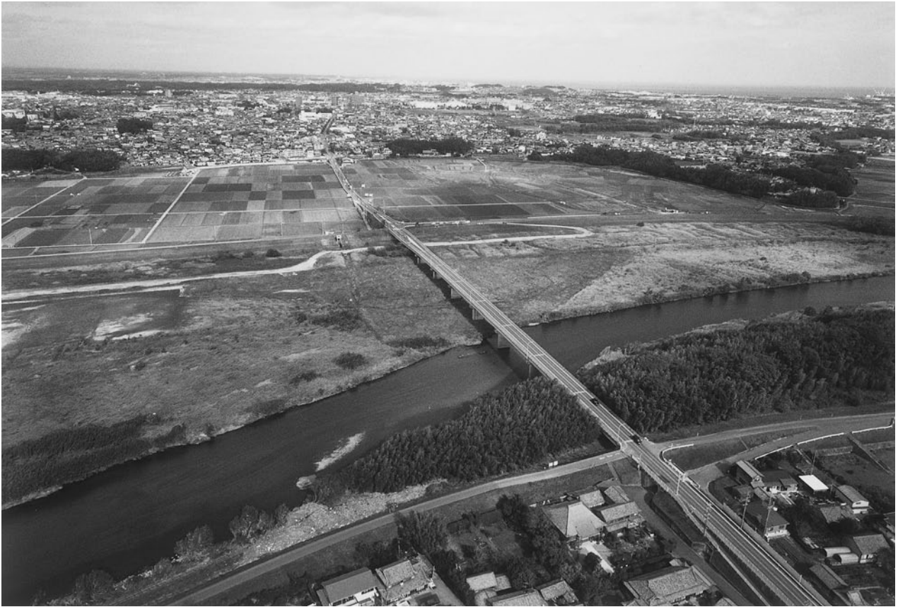
調査前風景（南側上空から）
