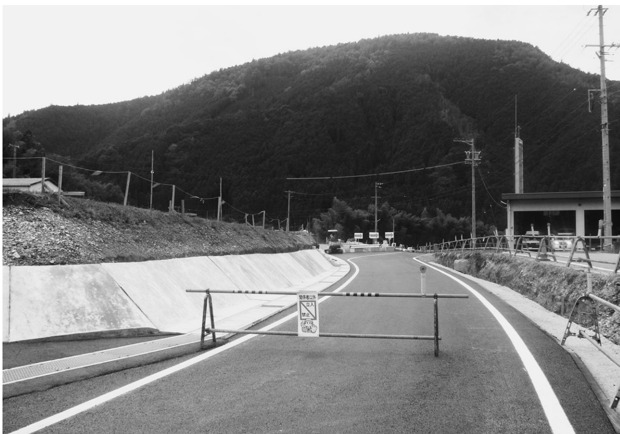
工事中の状況
