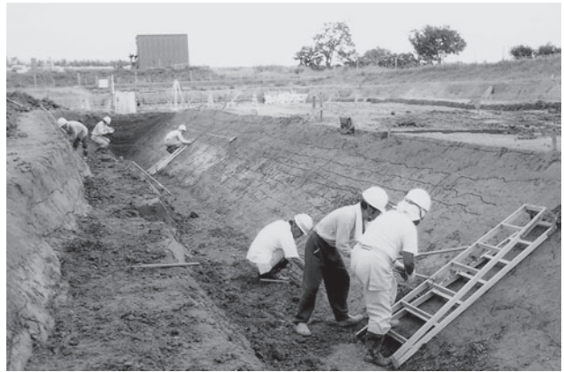
下層断ち割り調査風景 (南から)
