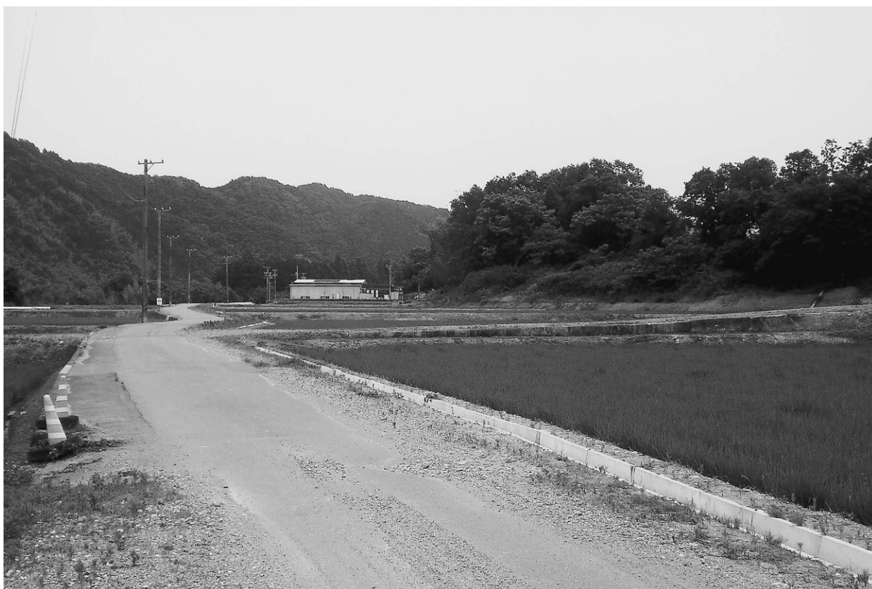
工事完成後 東沖遺跡を望む(西から)
