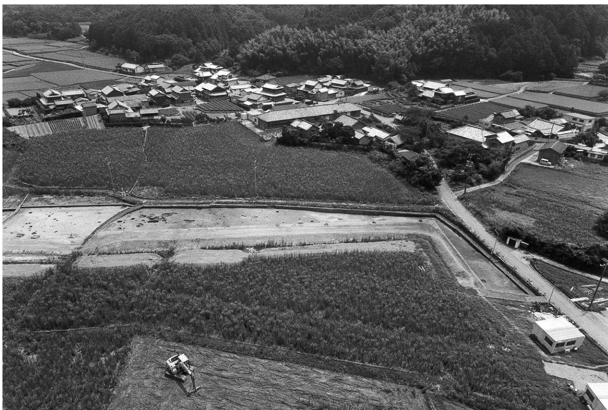
A地区・B地区付近(北西から)
