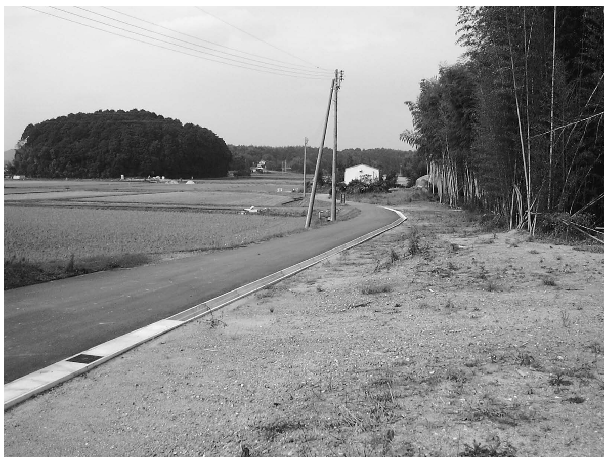
調査区工事後状況 (東から)
