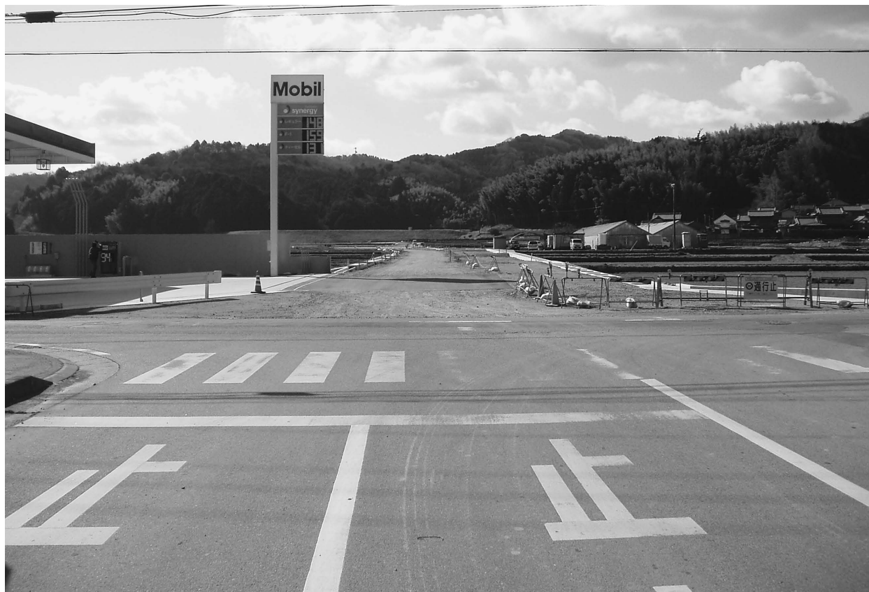
調査区工事後状況（北から）
