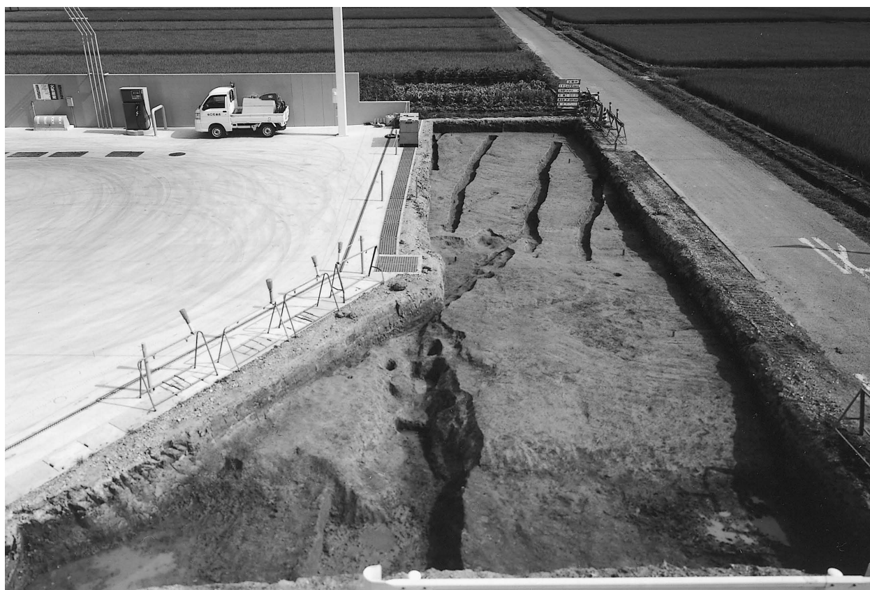
調査区完掘状況（北から）
