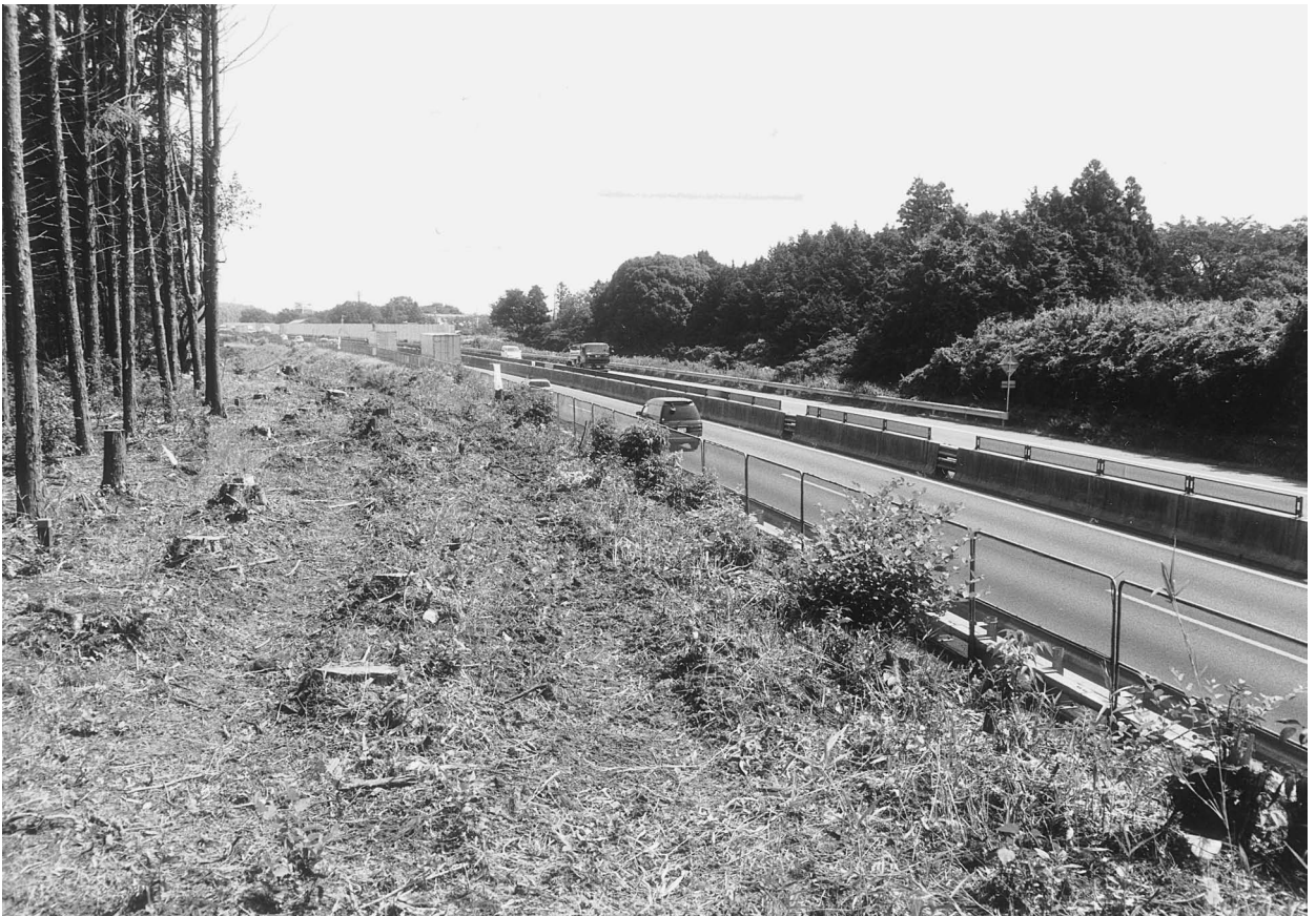
調査前風景（南東から）
