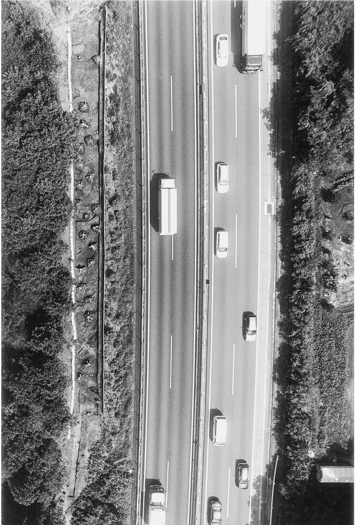
調査区全景（直上から 写真上が北東）
