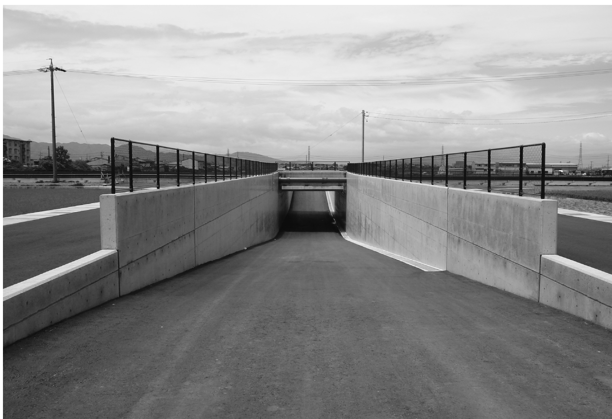
工事完成後全景（東から）
