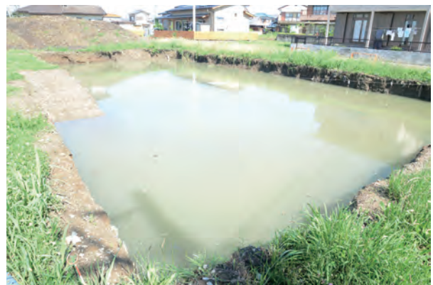
調査区水没状況（南東から）
