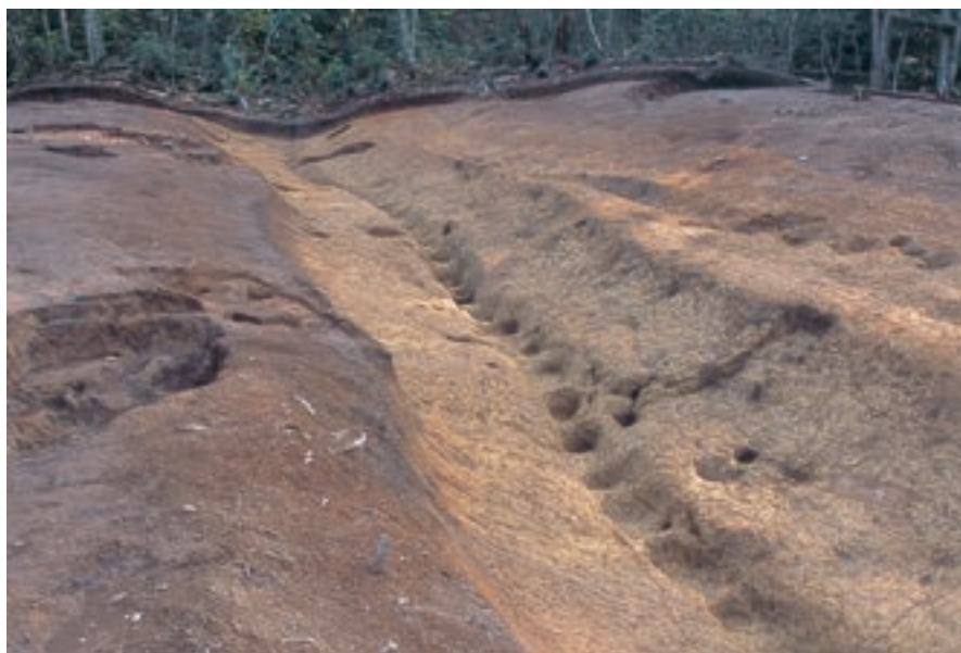
1. 道路1完掘（北東より）
