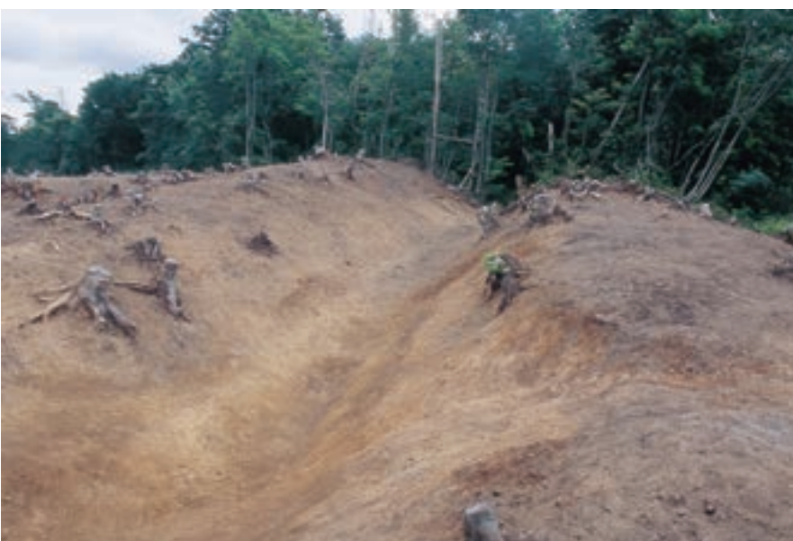
3. 交通壕完掘（北西より）
