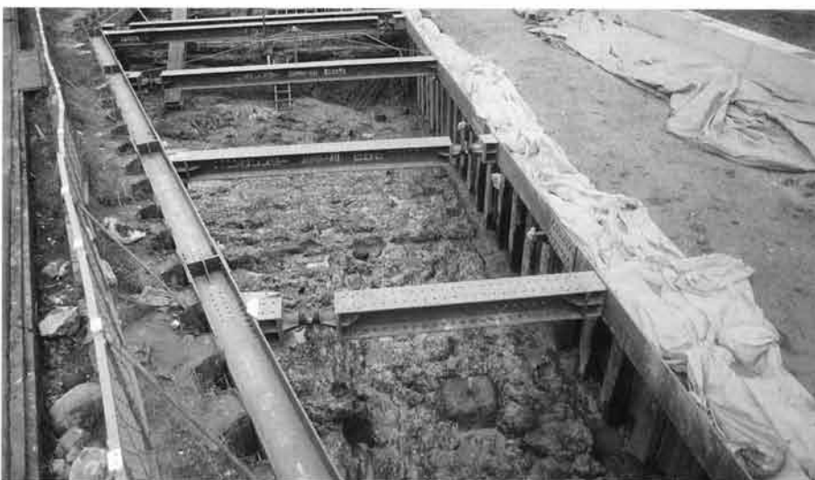
2・1～4区波蝕台検出状況（南より）
