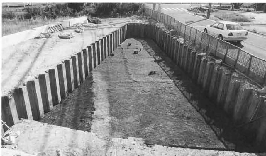
1・1～4区、第2水田（北より）
