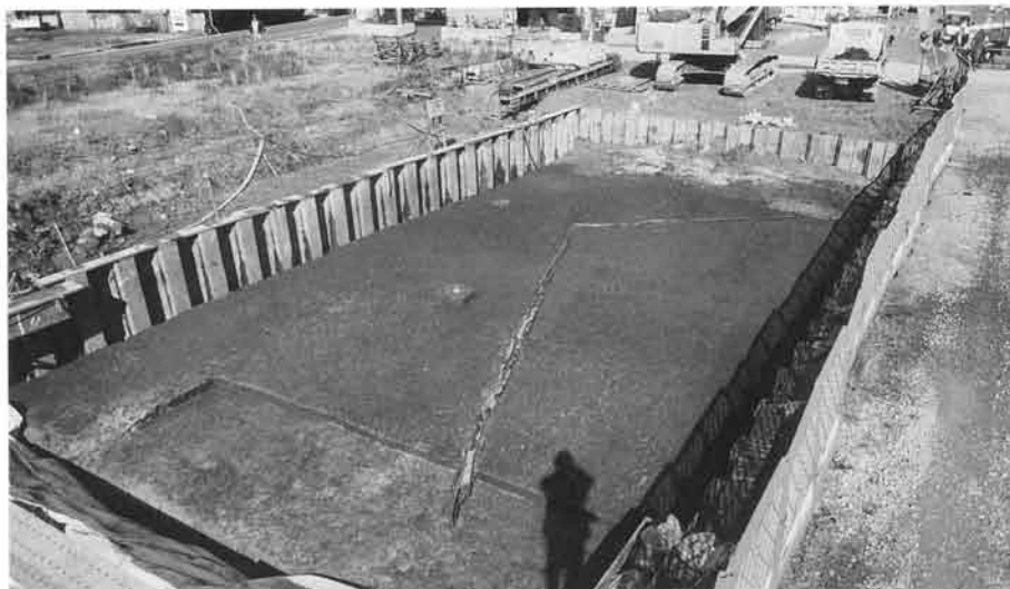
1・近世の暗渠状遺構（南より）
