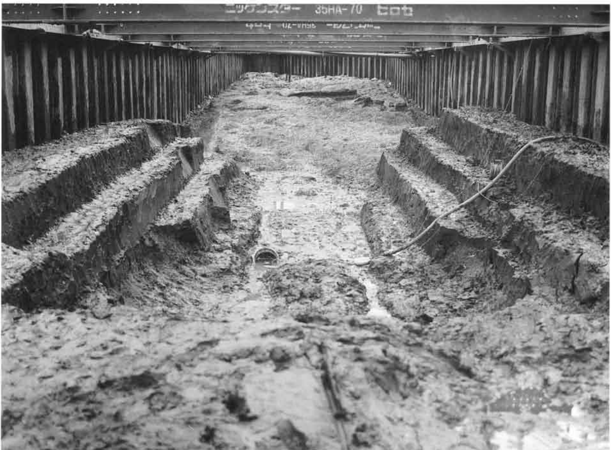
2・基盤層検出状況（11区より西を見る）
