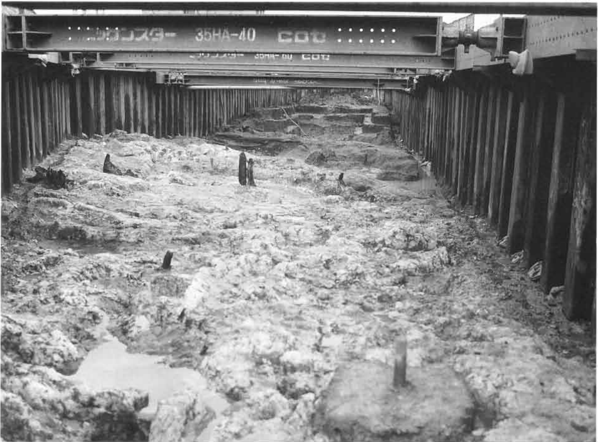
1・基盤層検出状況（2区より東を見る）
