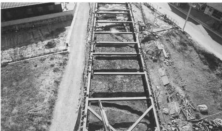
3・9～13区、水路1、水路2（北より）
