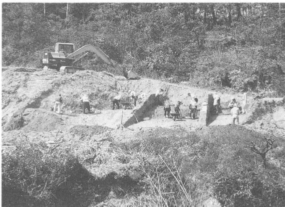
4・5テラス作業風景
