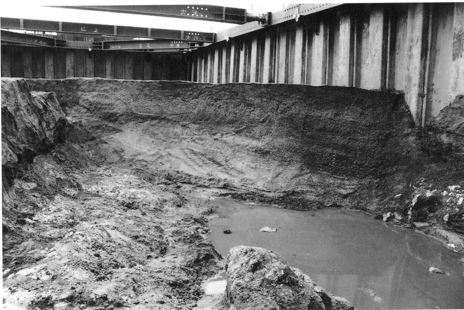
2. 水路1断面A (西より)
