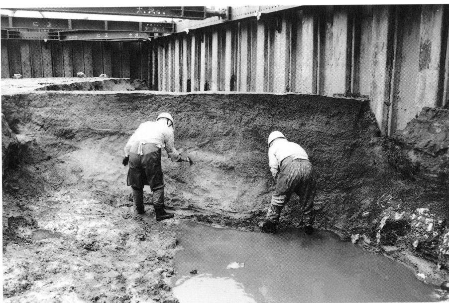
3. 水路1断面A (西より)
