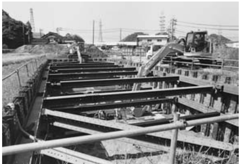
2. 排土の搬出状況（東より）
