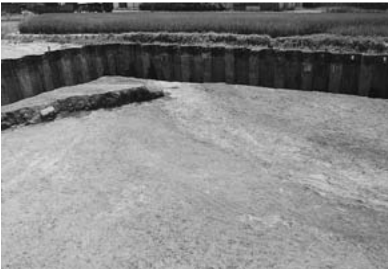
2. 水路1 検出（北より）
