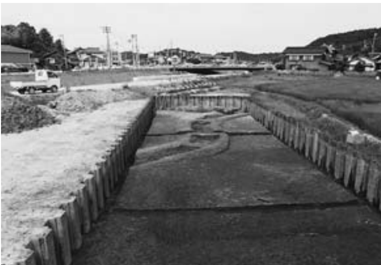
3. 水田面完掘（南西より）
