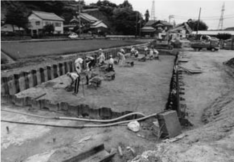
1. 調査風景（北東より）
