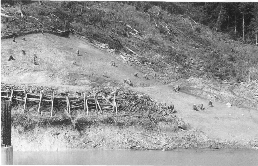
2区・3区全景（北から）
