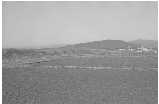
写真2 建設中の国道163号線B P (東から、奥は長谷山)
