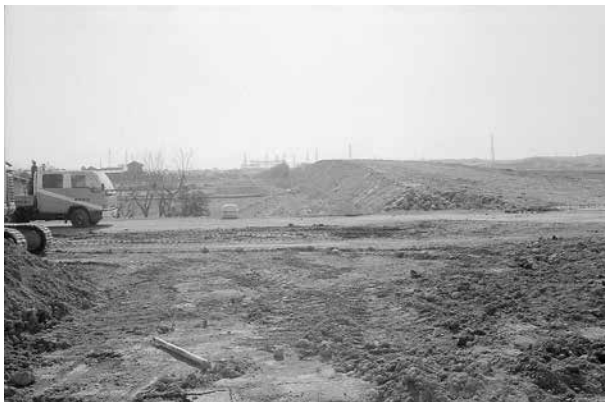
写真1 建設中の国道163号線B P (西から、奥は津市街)
