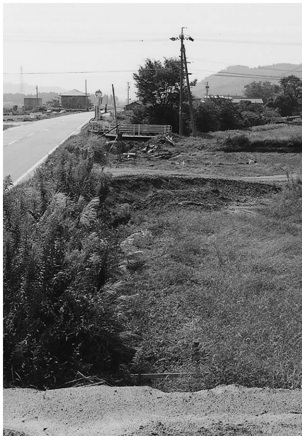
D地区調査前風景（北から）
