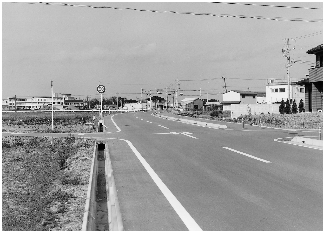
事業完了後（南東から）
