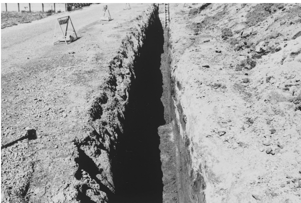
No. 4 トレンチ完掘状況
