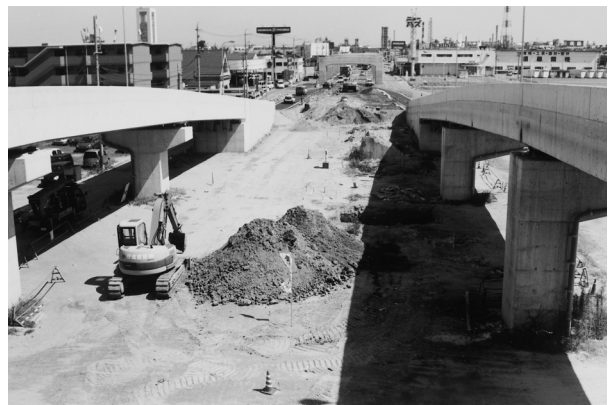
CP1 トレンチ堀削前状況
