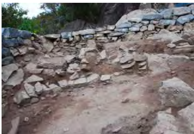
39- 1 甕城石積み前面石積み撤去状況（南から）
