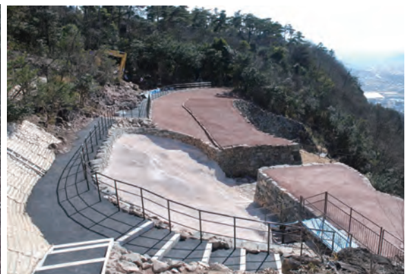
写真 216 城内舗装状況（北から）
