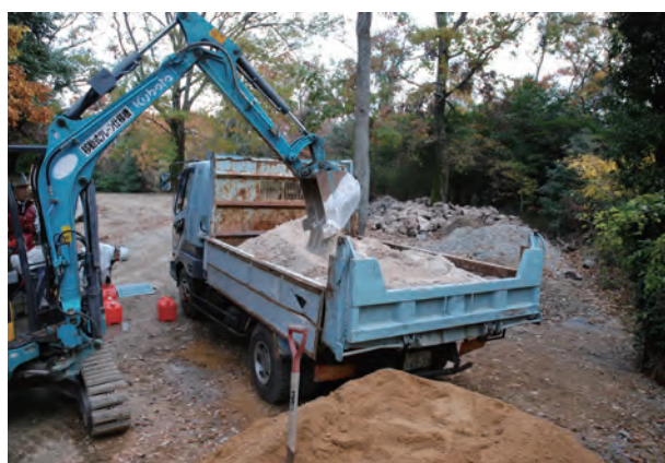
写真 129 酸化マグネシウム攪拌状況
