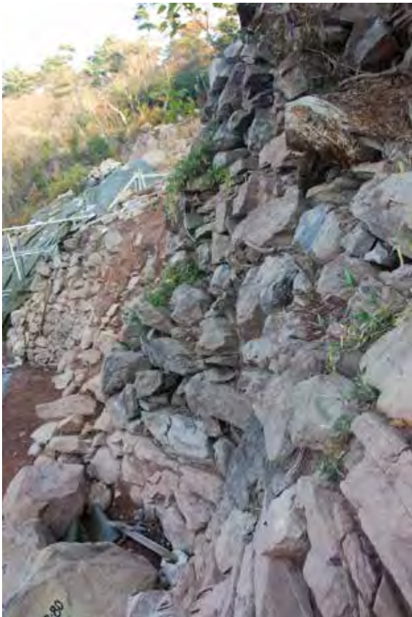
8- 1 高石垣のテラス部分（南から）
