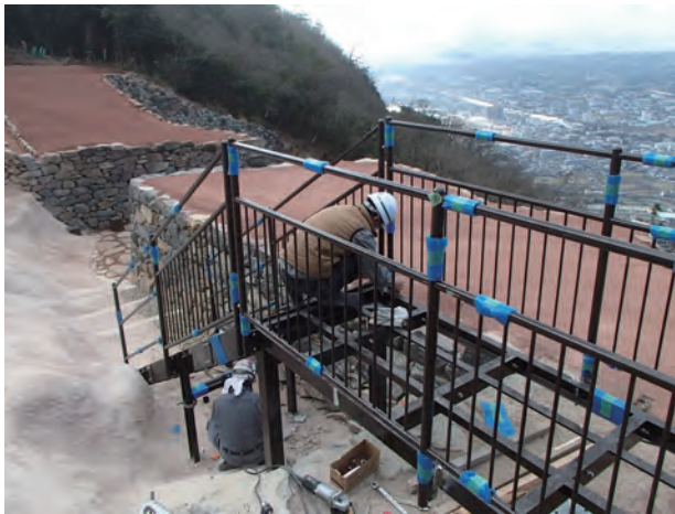
写真 211 階段設置状況（北から）
