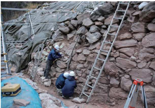
写真 78 石積清掃状況（南から）
