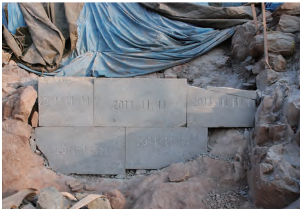
写真 107 基礎石設置完了状況（西から）
