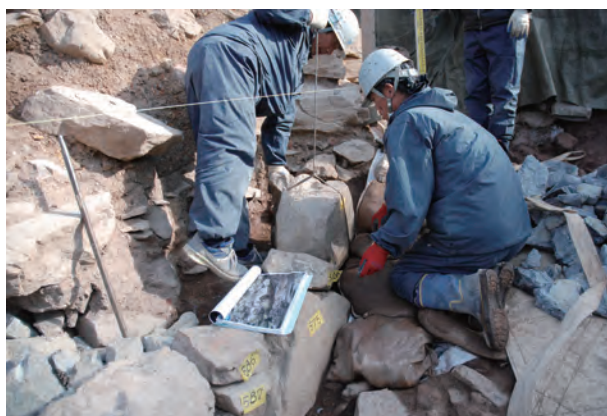
写真 98 北側城壁石積み状況②（西から）
