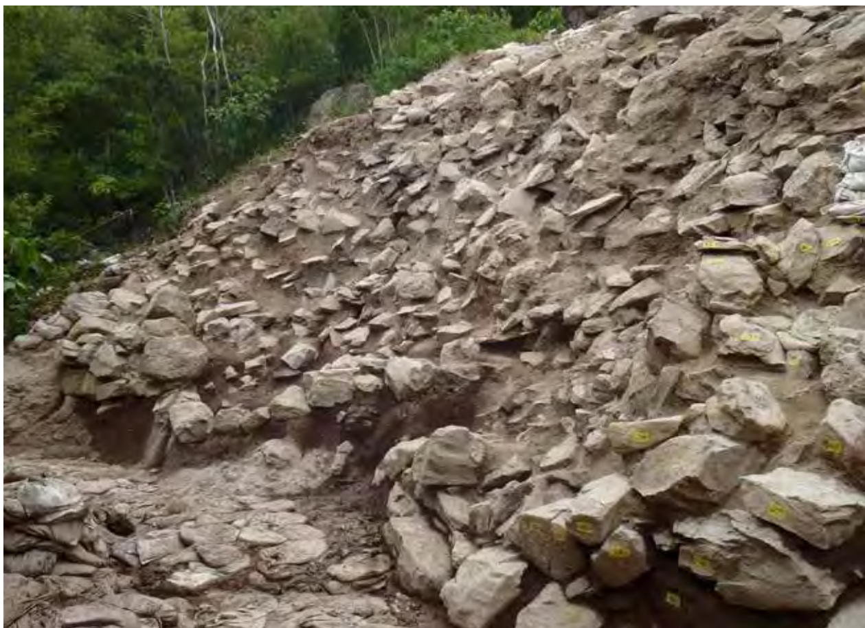
17- 1 城門北側城壁解体後状況（南から）
