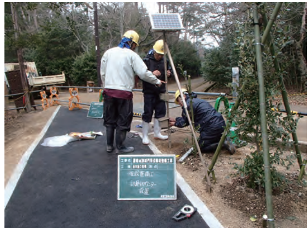
写真 222 見学路①カウンター設置状況（西から）
