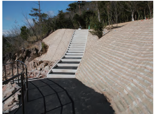
写真 202 植生マット設置完了状況（南から）
