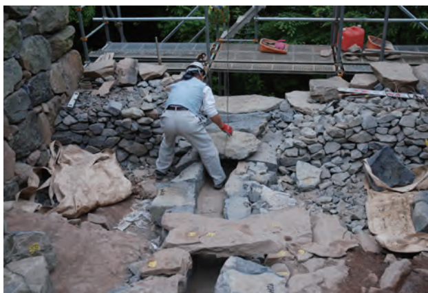
写真 118 蓋石設置状況①（東から）
