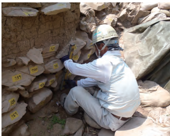
写真 80 墨打ち状況（南から）
