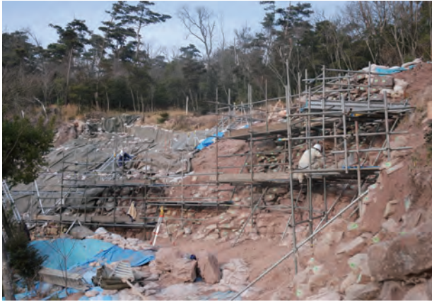
写真 72 解体前遠景（南西から）
