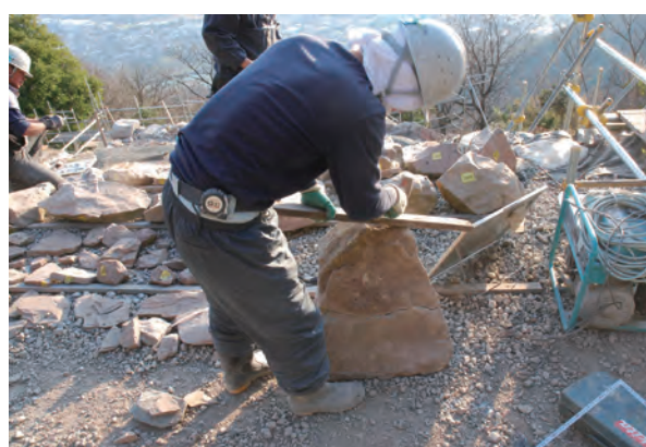
写真 150 接着状況②
