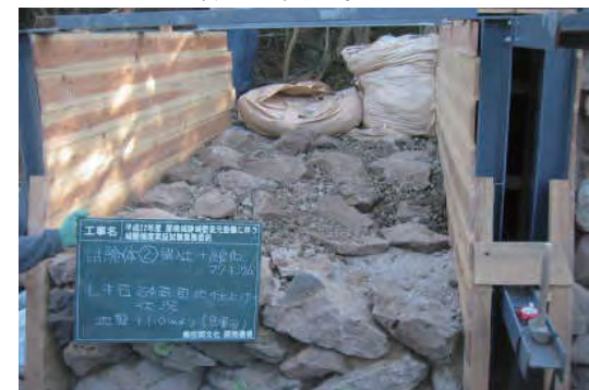
写真 54 土石層の石材敷き並べ状況②
