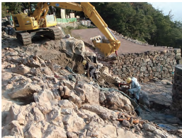
写真 191 作業ヤード撤去状況（北から）
