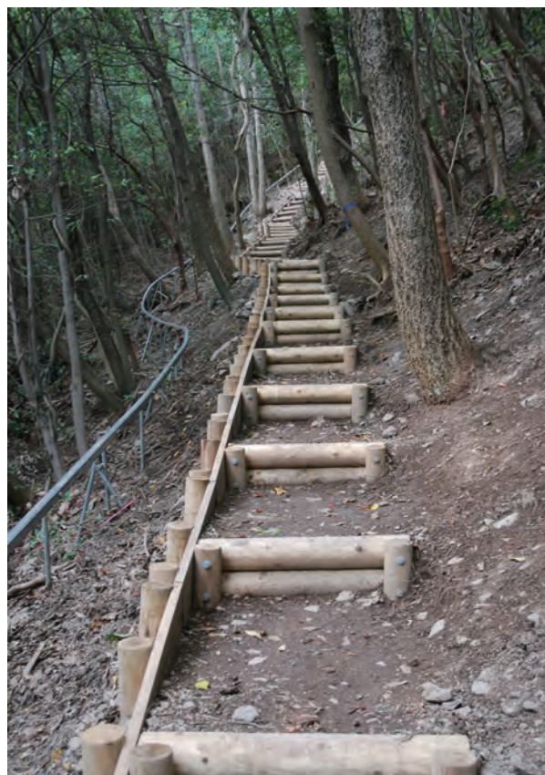
写真 230 見学路②完成状況（南西から）
