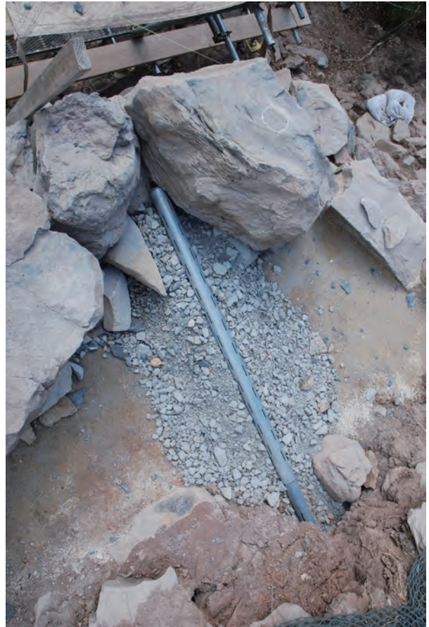
写真 153 排水補強パイプ設置状況②（南から）
