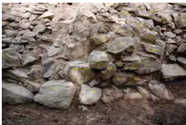
17- 5 城門北側城壁根石④（西から）
