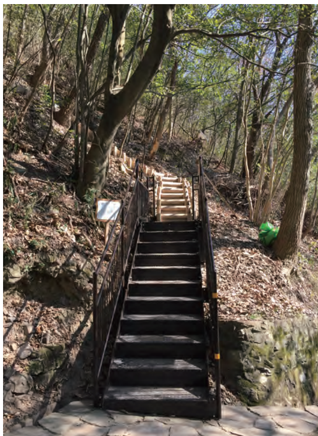
写真 229 見学路②起点の鋼製階段設置状況（北西から）
