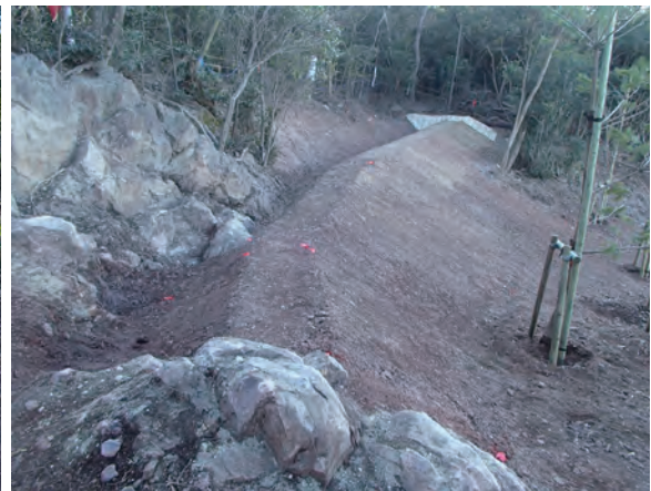
写真 214 土堤部施工状況①（北から）
