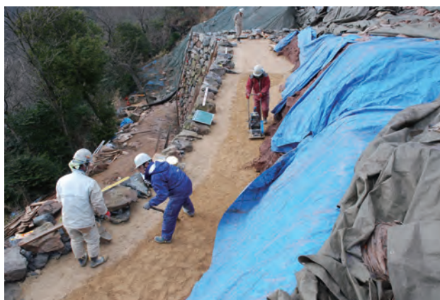
写真 134 機械転圧状況（南から）
