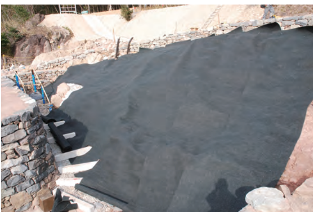
写真 165 土舗装③不織布敷設状況（南から）
