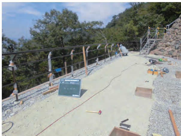
写真 180 転落防止柵設置状況（南から）
