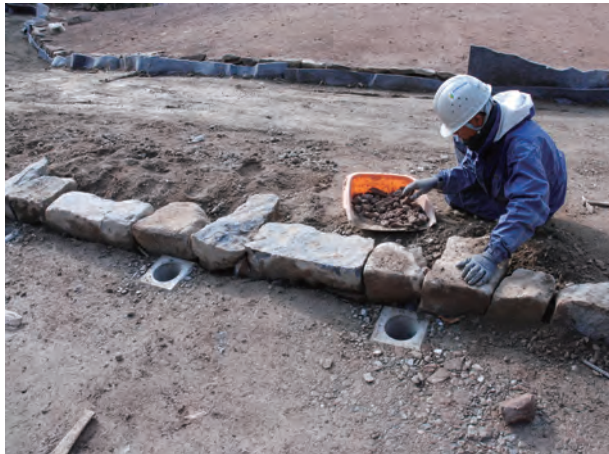
写真 196 背面列石遺構明示工（北東から）
