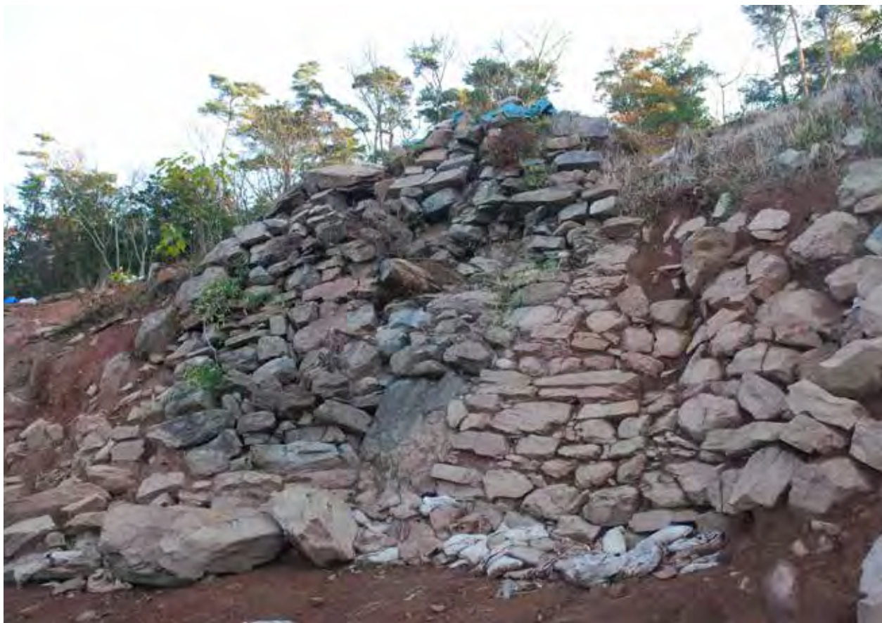
7-2 高石垣（南西から 平成 21 年度）
