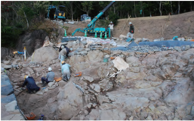
写真 155 甕城石積み撤去状況（南西から）
