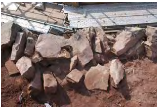
12- 2 高石垣石積み及び背面の状況②（東から）
