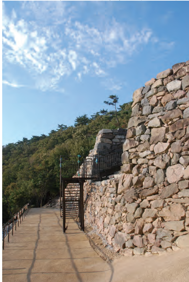
写真 185 城外側施工完了状況（南から）
