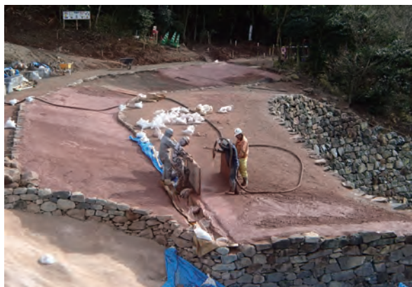
写真 205 土舗装④⑤施工状況（北から）
