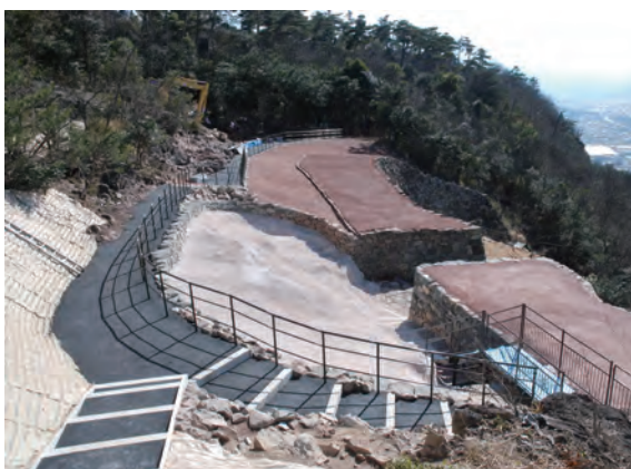
写真 170 土舗装③吹き付け完了状況（北から）
