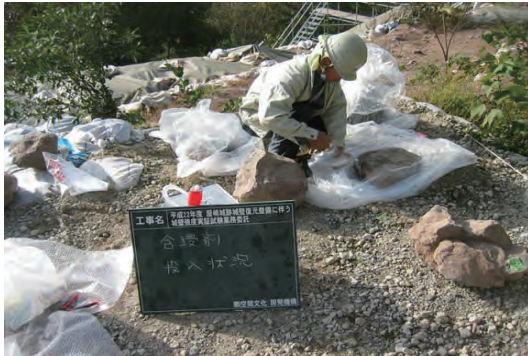
写真 39 石材薬材含浸状況①
