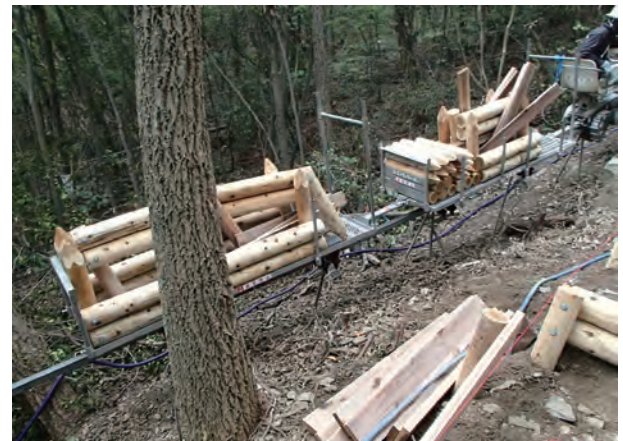
写真 224 見学路②施工用モノレール使用状況（東から）
