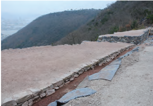
写真 103 南側城壁背面石積み完成状況①（南東から）
