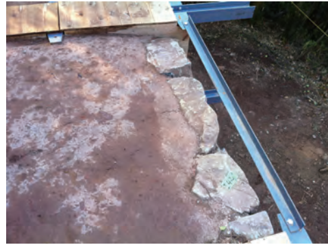
写真 62 経過観測 1ヶ月②城壁天端
