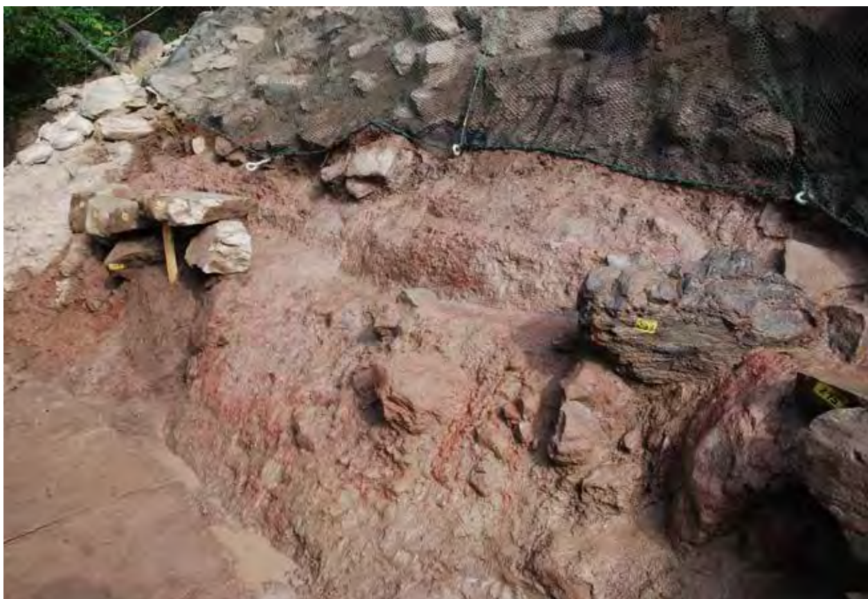
20- 3 城門北側城壁根石設置箇所岩盤加工状況（南西から）
