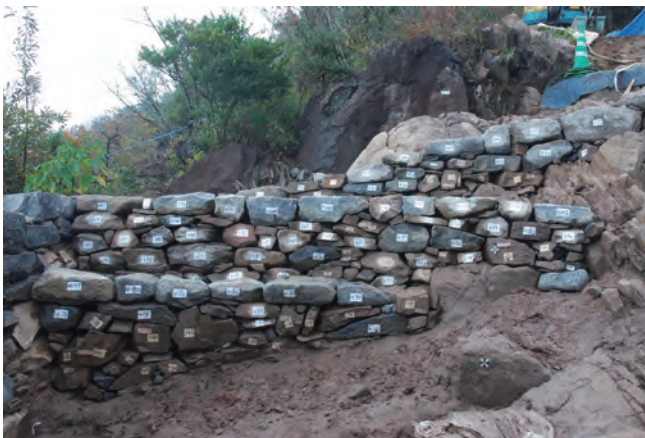
写真 159 甕城石積み完了状況①（南から）
