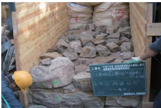
写真 53 土石層の石材敷き並べ状況①
