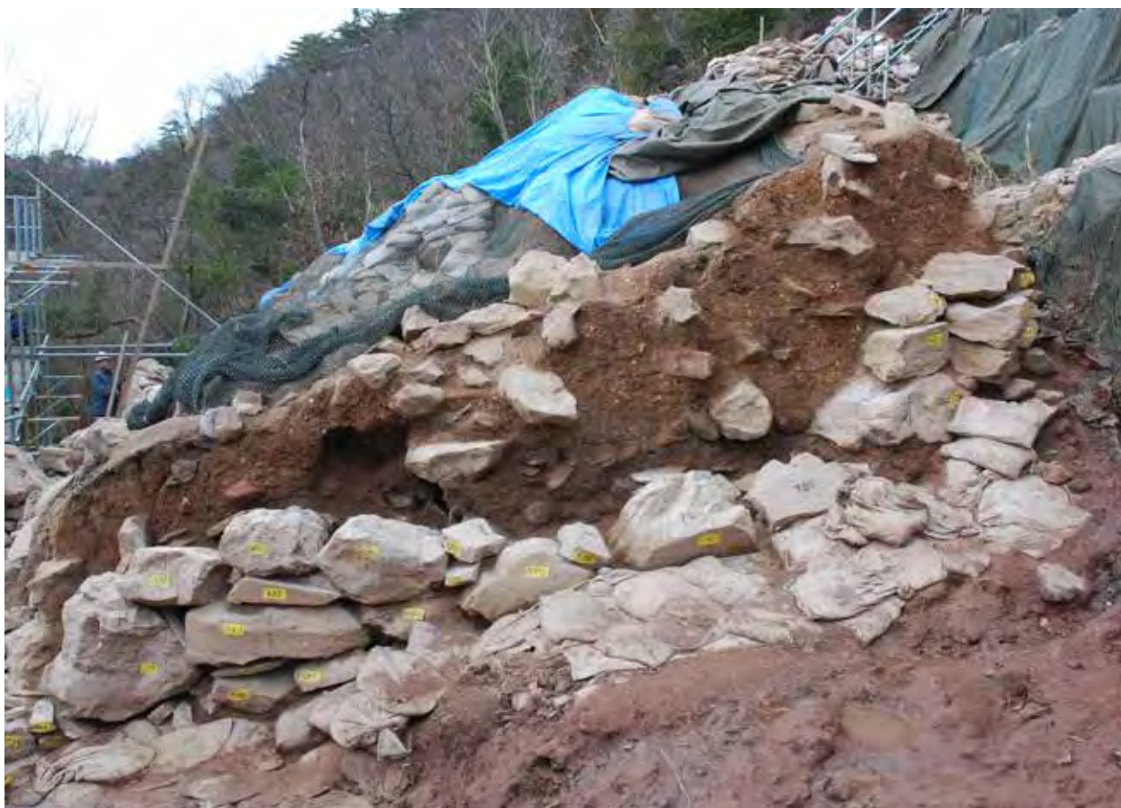
23- 2 城門北側壁背面土層（南から）
