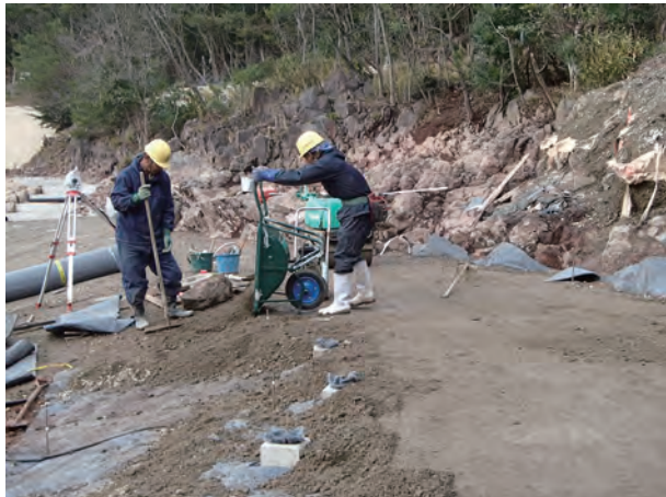
写真 193 城内造成状況②（南から）
