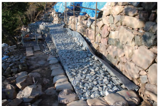
写真 110 北側城壁根石補強かごマット設置完了状況（北から）
