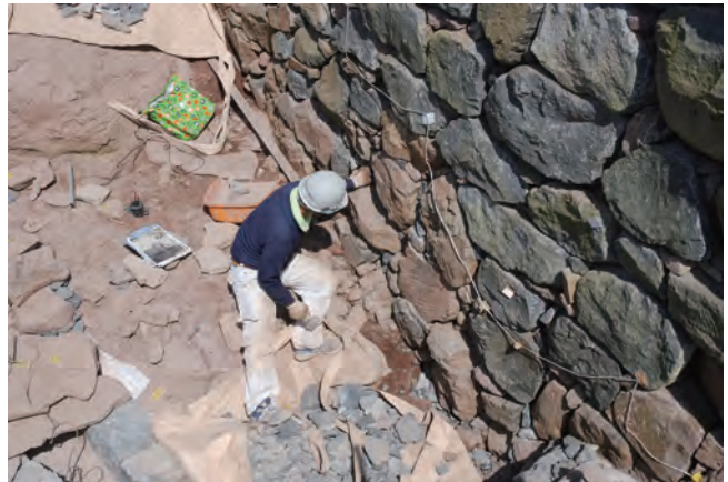
写真 122 門道埋没部分の目地詰め状況（南から）
