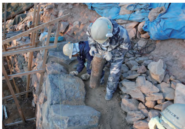
写真 133 人力転圧状況（南から）
