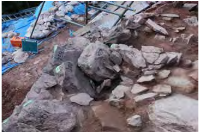
8- 3 高石垣のテラス上部解体後の状況（南から）
