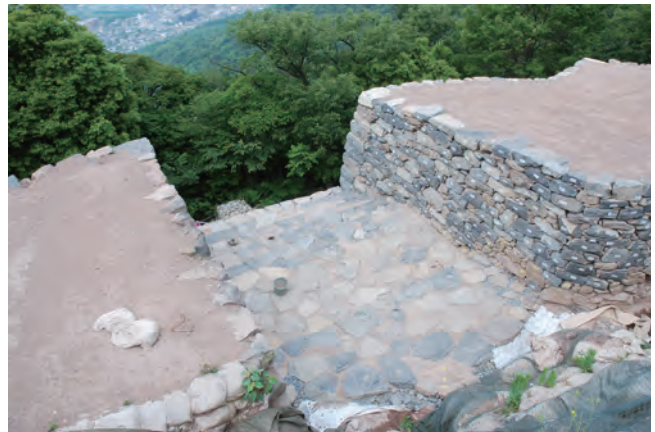
写真 126 門道復元完了状況（南東から）
