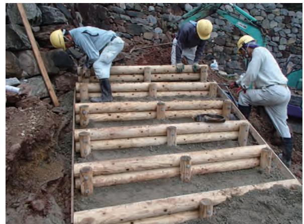
写真 178 城外側階段設置状況（北西から）
