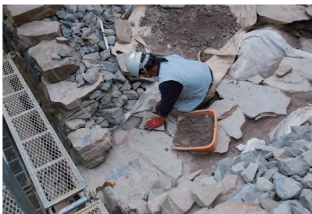
写真 114 敷石設置状況（南西から）
