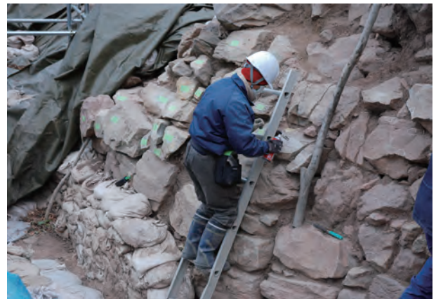
写真 79 番付状況（南から）
