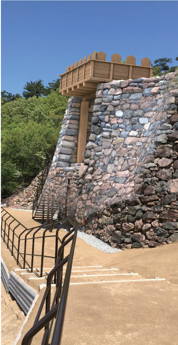
写真 238 現地に甦った屋嶋城の城門①（城外側）
