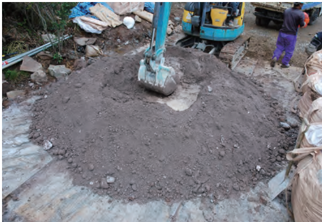
写真 139 水の追加状況（北から）
