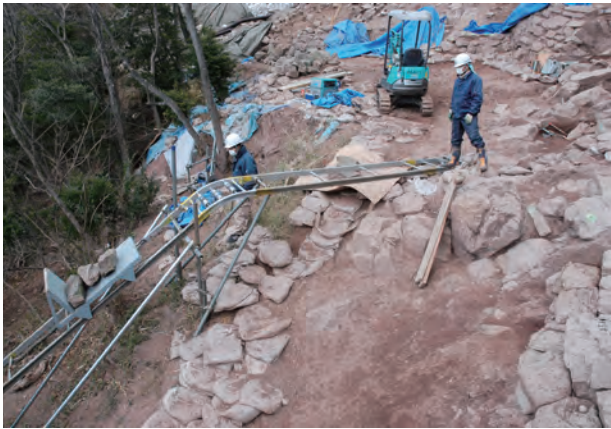
写真 76 転石回収状況④（南から）
