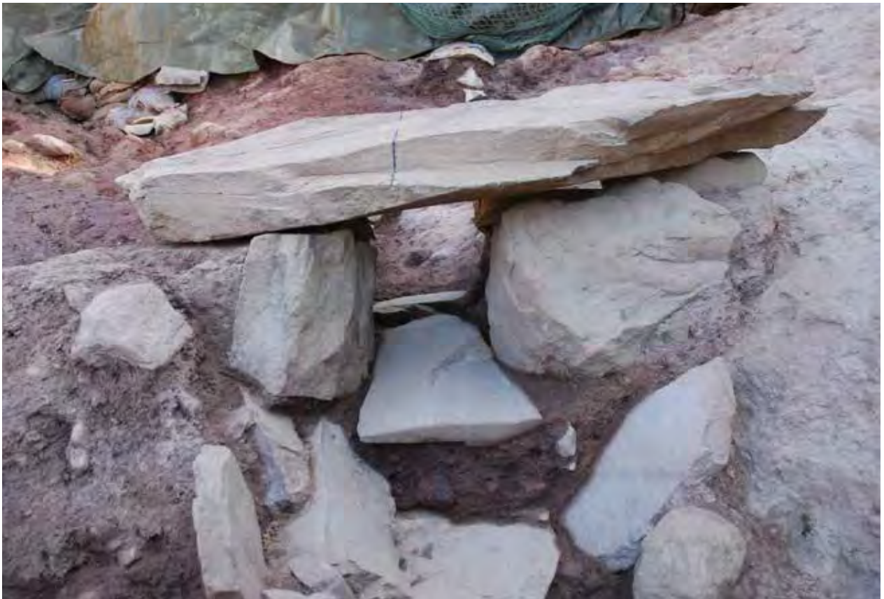
30- 5 排水溝蓋石修復後状況（西から）
