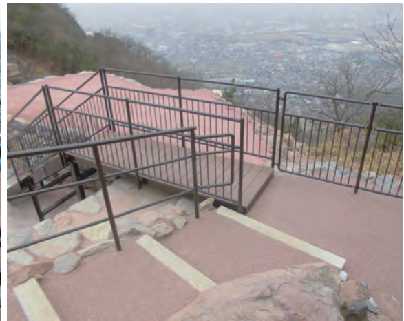
写真 212 階段設置完了状況（北東から）
