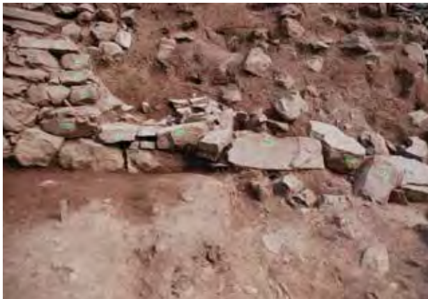
14- 1 高石垣南側根石詳細① (西から)
