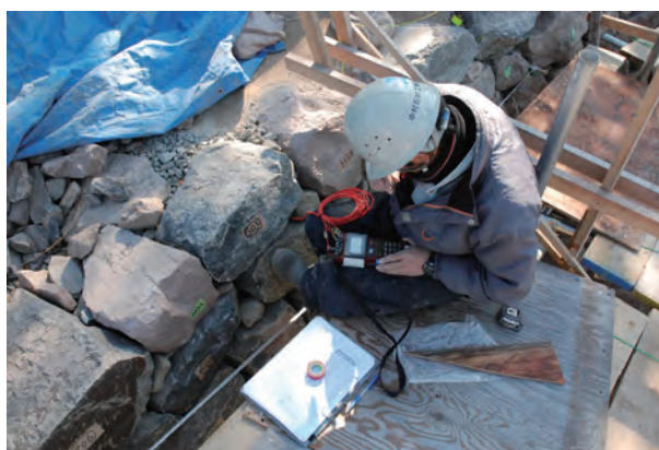
写真 234 ひずみ計計測状況②
