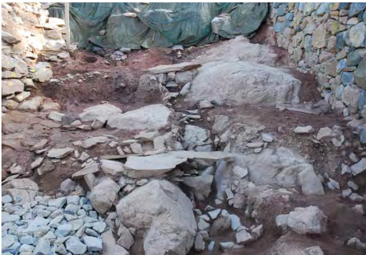
31- 1 排水溝蓋石修復状況①（西から）
