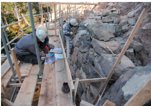
写真 94 検討状況（南から）
