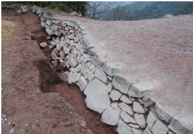
写真 105 南側城壁背面石積み完成状況③（南東から）
