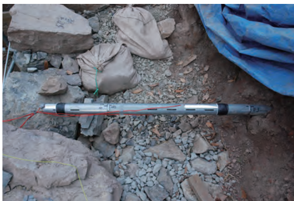
写真 231 ひずみ計設置状況①
