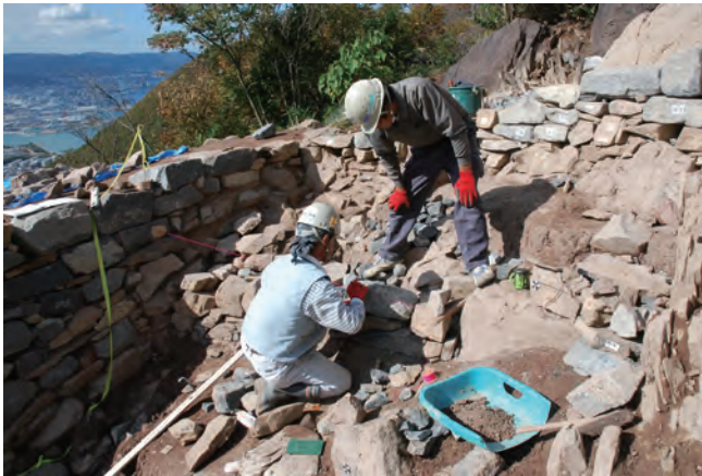
写真 157 甕城石積み状況②（南東から）
