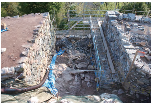
写真 117 側石設置状況②（東から）
