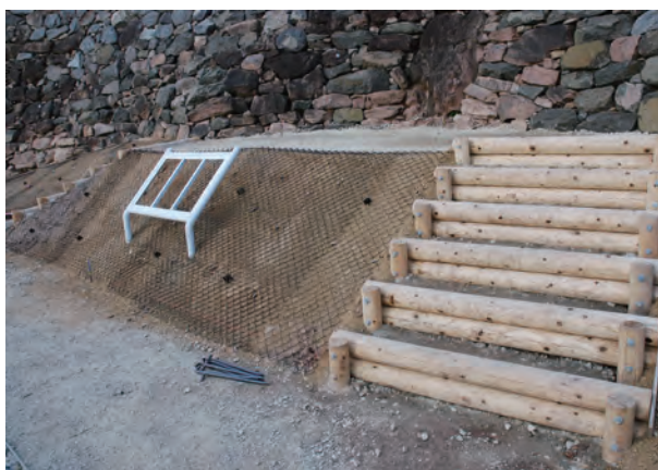
写真 182 土舗装2ラス網設置状況（南西から）
