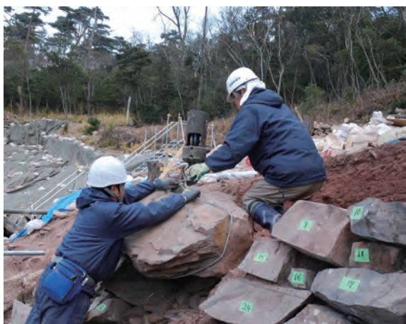
写真 84 石積み解体状況①（南西から）
