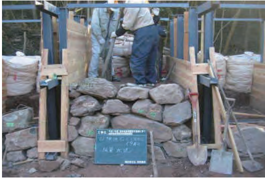
写真 45 人力つき固め状況②
