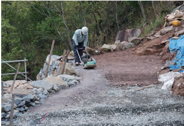
写真 141 転圧状況（南から）
