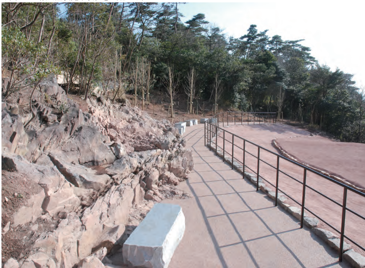
写真 208 城内舗装完了状況②（南から）
