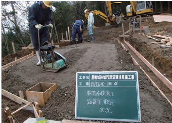
写真 217 見学路①造成状況①（南から）
