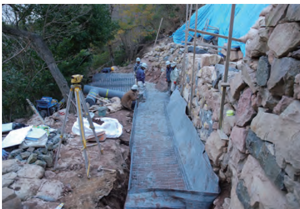
写真 109 北側城壁根石前面補強かごマット設置状況（北から）
