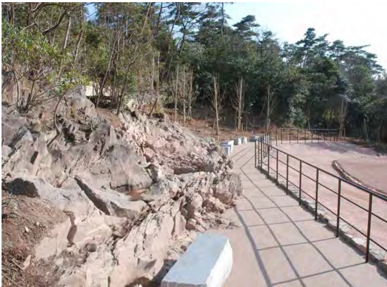
35- 5 背面列石の背面にある岩盤（通路状を区画するように一段高くなっている：北から）
