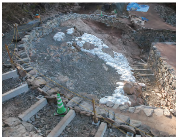
写真 164 土舗装③施工前凹地造成状況（北から）
