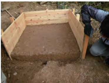
③つき固め完了状況
