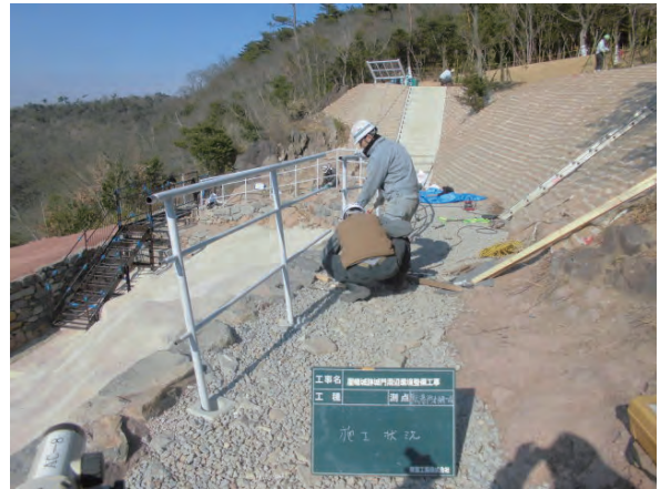
写真 200 人止め柵設置状況（南から）
