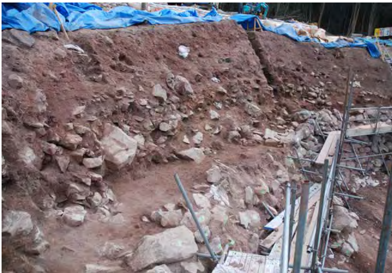
11- 1 城壁土層（上層：盛土層、下層：土石層；北西から）
