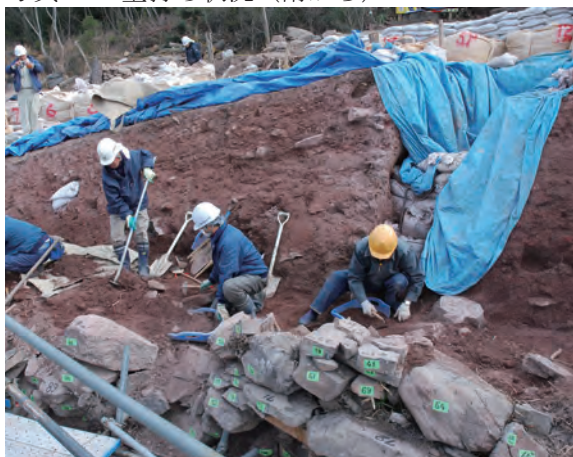
写真 82 盛土掘削状況②（南西から）
