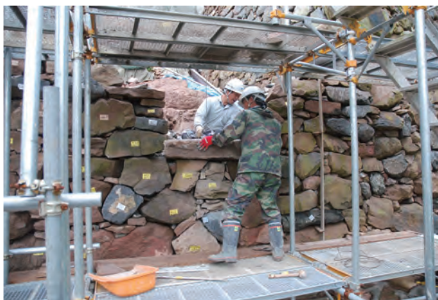
写真 111 水口位置決め作業状況（西から）
