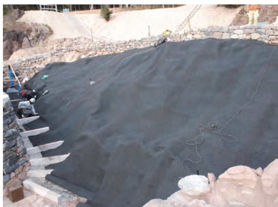
写真 166 土舗装③ラス網敷設状況（南から）
