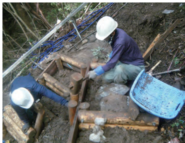
写真 226 見学路②設置状況①（南から）
