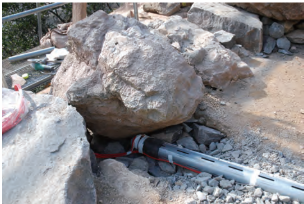
写真 152 排水補強パイプ設置状況①（南東から）
