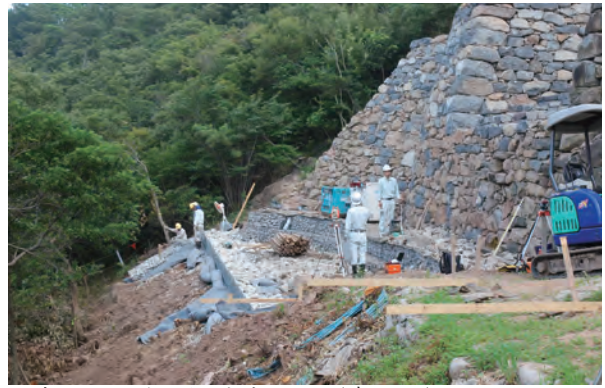
写真 172 城外側造成状況（南から）
