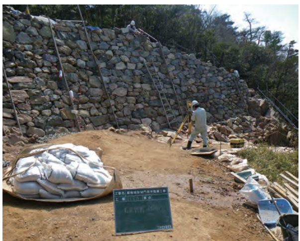
写真 237 定点観測状況
