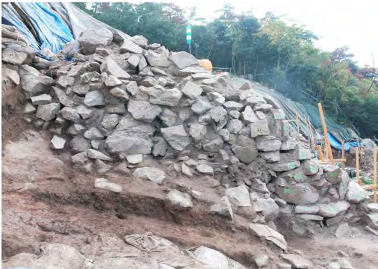
14- 5 南側壁背面埋込石積み (北から)
