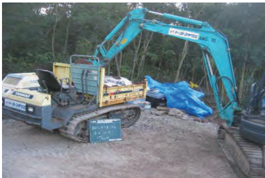
写真 43 酸化マグネシウム攪拌状況
