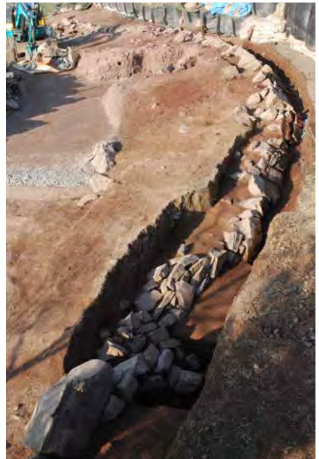
16- 6 南側城壁城内側石積み⑥（南から）
