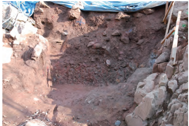
写真 106 根石設置箇所風化岩盤撤去状況②（西から）
