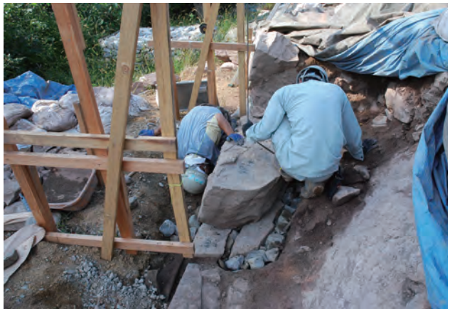
写真 95 南側城壁石積み状況①（南から）
