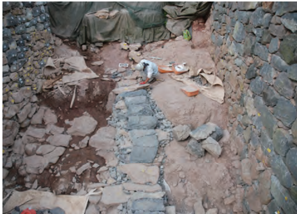
写真 119 蓋石設置状況②（西から）
