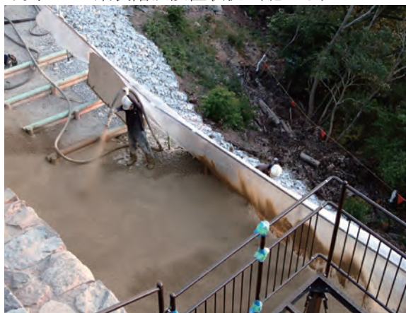
写真 183 土舗装1・2施工状況（北東から）
