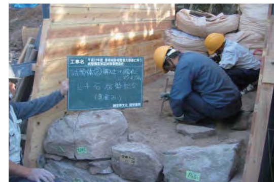
写真 52 土石層つき固め状況
