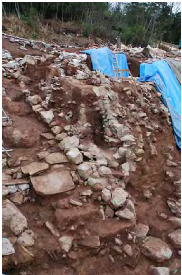
10- 2 南側壁解体状況（北東から）
