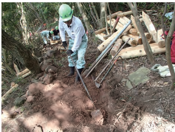
写真 225 見学路②掘削状況（南東から）
