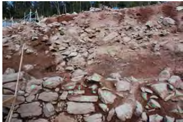
10- 4 南側壁背面埋没石積みの背面の土石層（西から）
