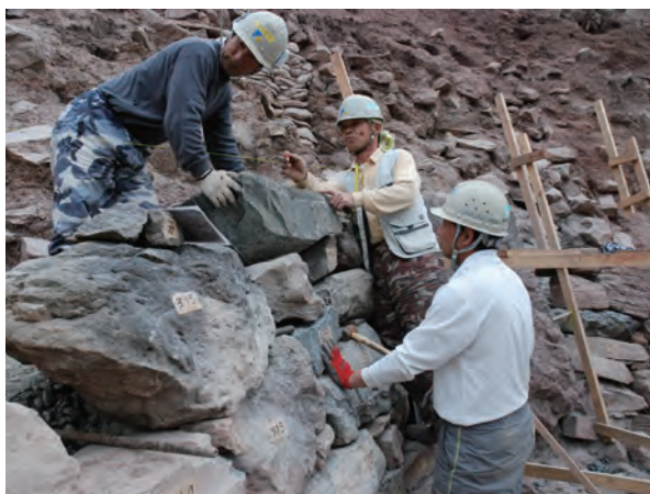
写真 96 南側城壁石積み状況②（北から）
