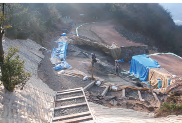
写真 169 土舗装③吹き付け状況②（北から）
