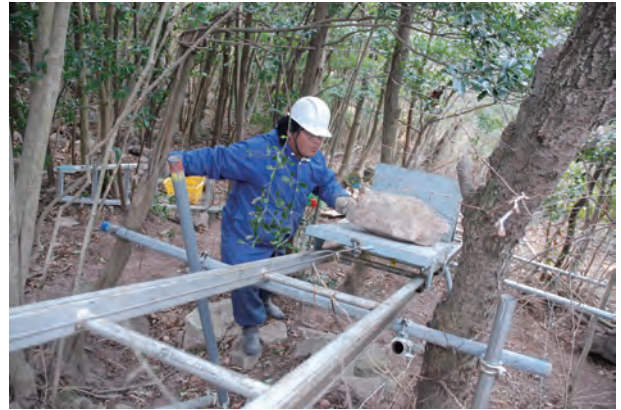
写真 75 転石回収状況③（西から）
