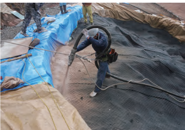
写真 167 土舗装③吹き付け状況（北から）
