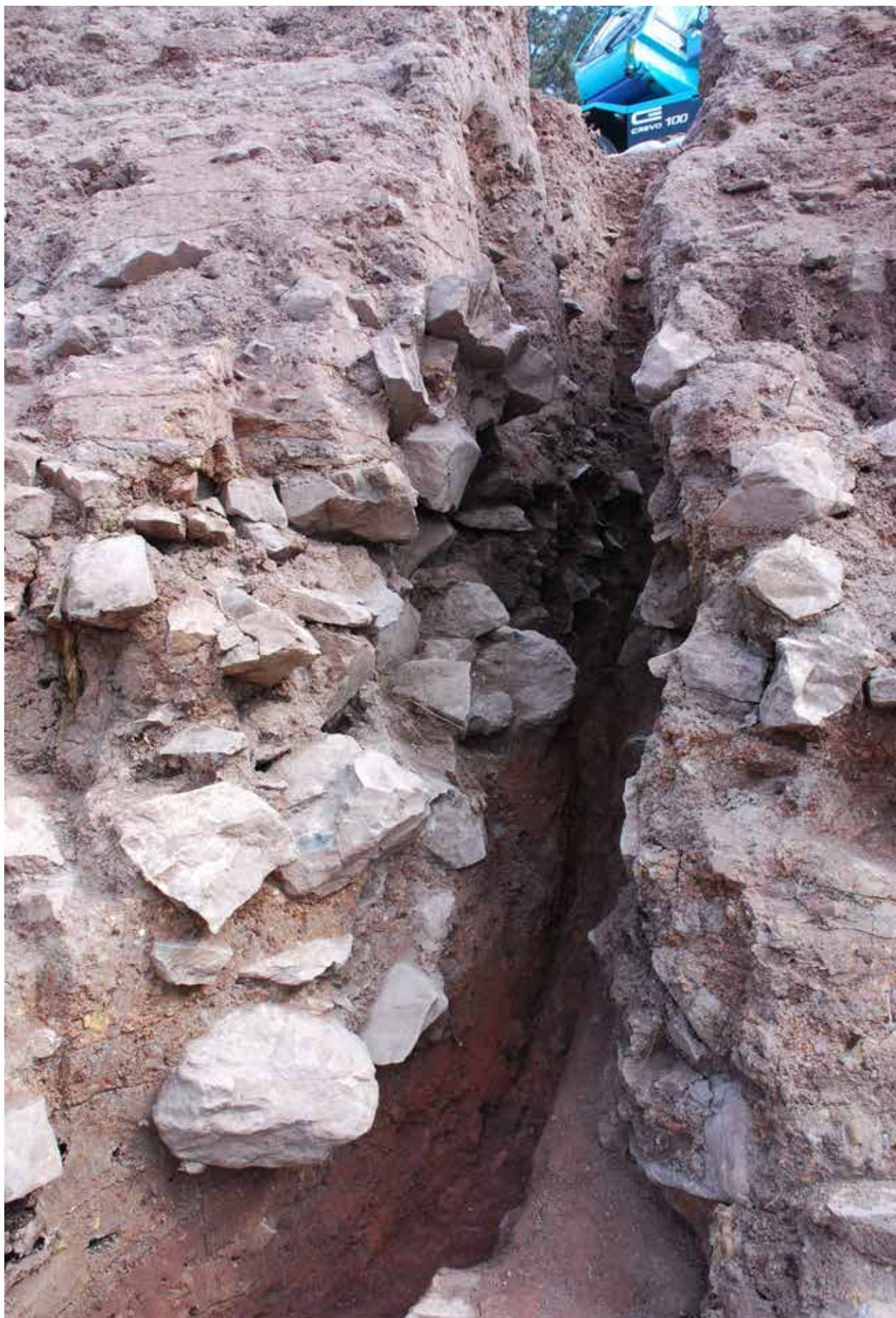
9-1 高石垣の断割り状況（西から）
