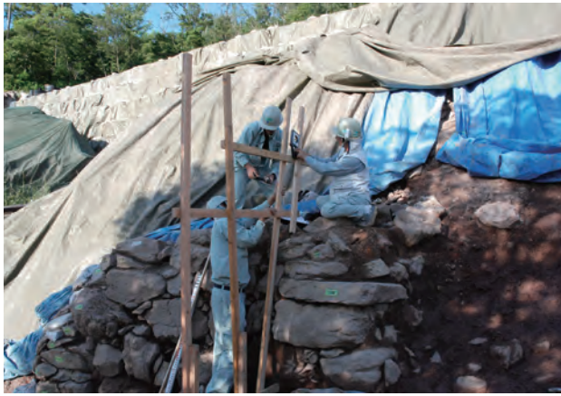
写真 88 丁張り設置状況（南西から）
