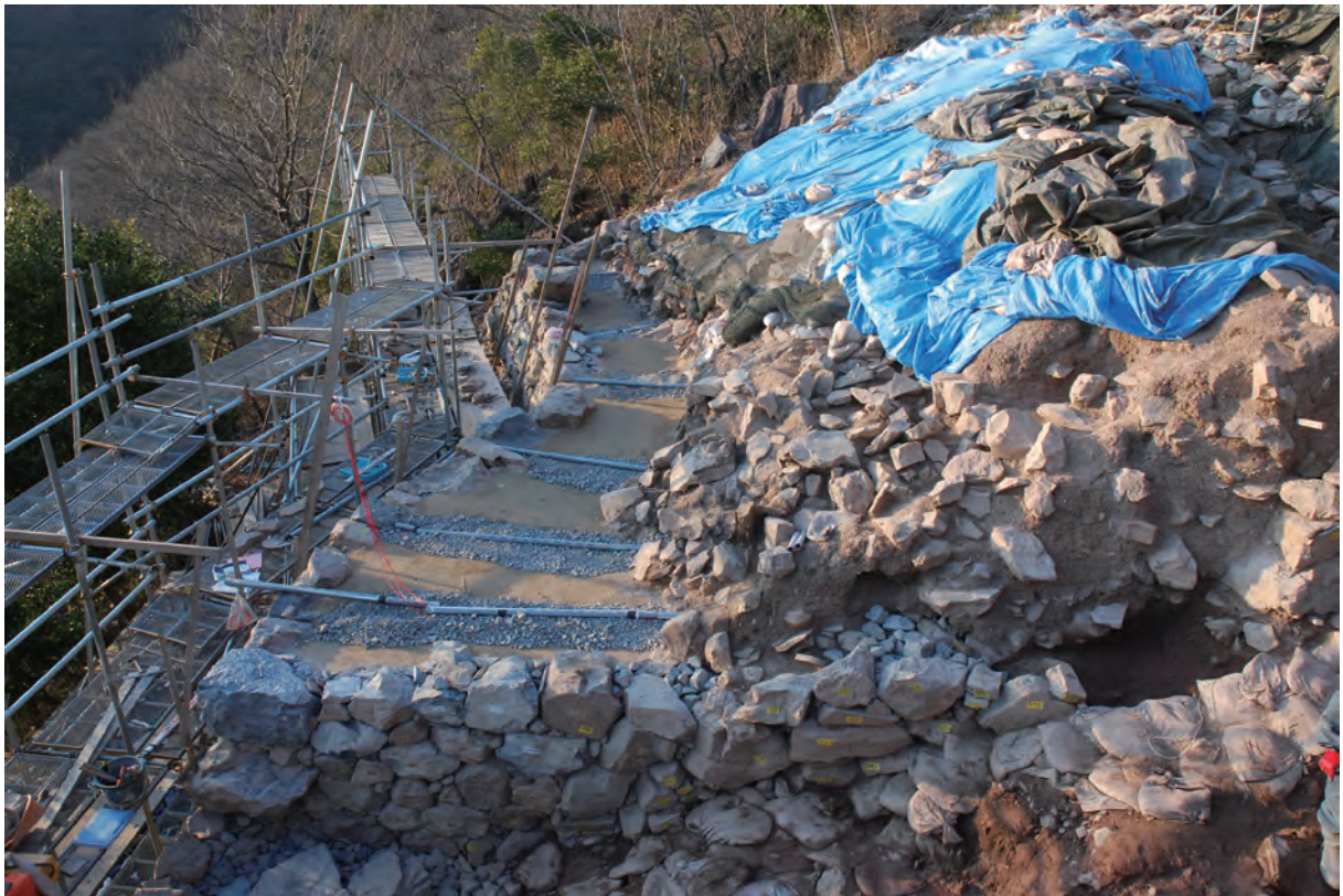
写真 154 排水補強パイプ設置状況③（南から）
