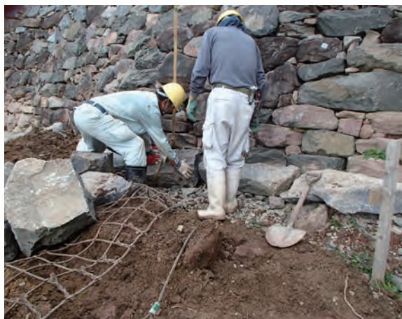
写真 179 城壁根固め状況（南西から）
