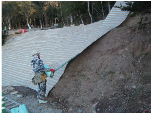
写真 201 植生マット設置状況（南から）
