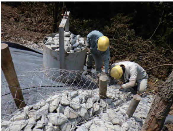
写真 175 じゃかご設置状況①（東から）
