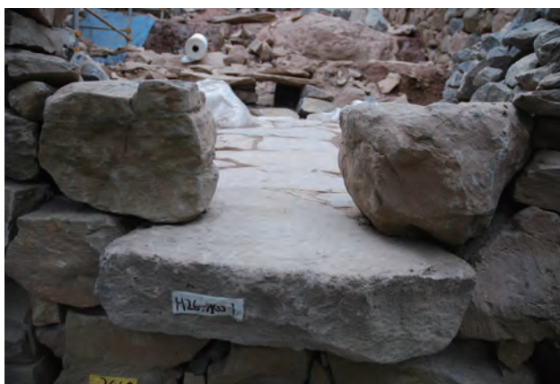
写真 115 敷石設置完了状況（西から）
