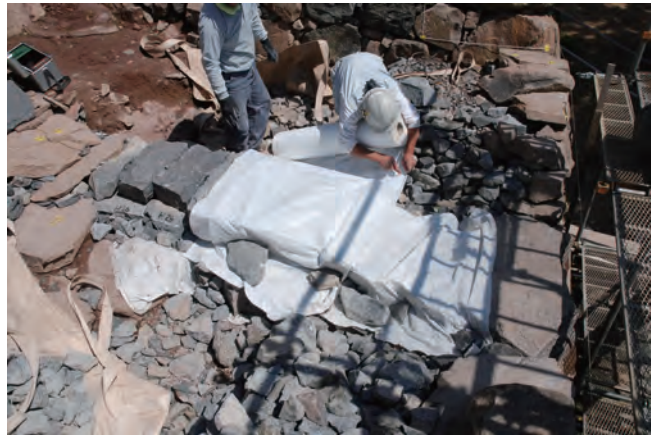
写真 120 不織布被覆状況（北西から）
