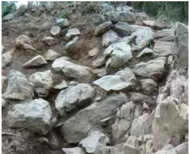
6-3 南端部岩盤取り付け部（西から 平成 19 年度）
