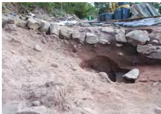
41- 3 甕城石積み（南側②：西から）
