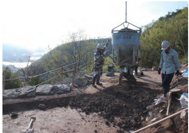
写真 140 撒きだし状況（南東から）
