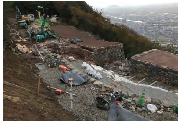
写真 156 甕城石積み状況①（北東から）
