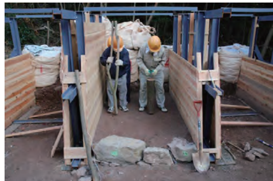
写真 44 人力つき固め状況①
