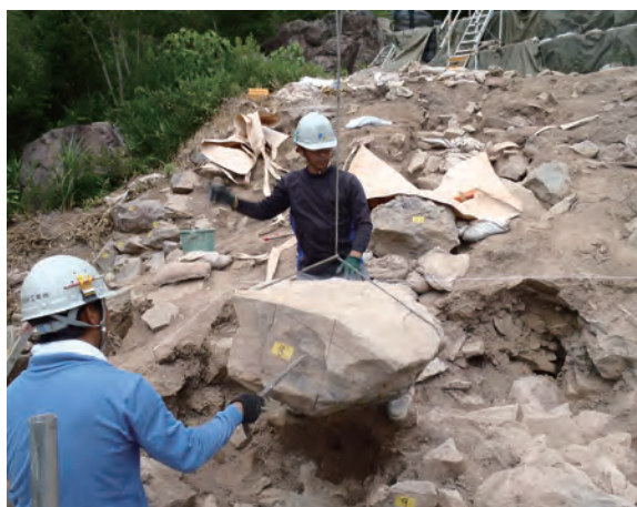
写真 85 石積み解体状況②（西から）
