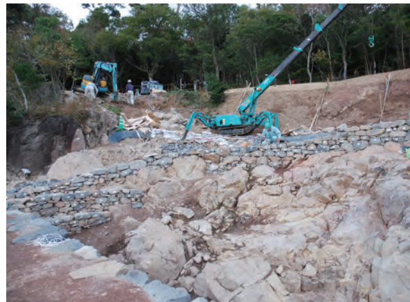
写真 162 甕城石積み完了状況④（南西から）
