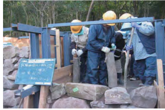
写真 46 人力つき固め状況③
