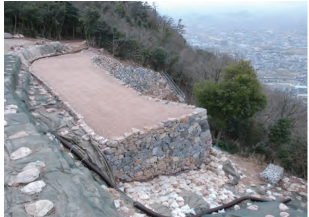
写真 142 盛土完了状況（北東から）
