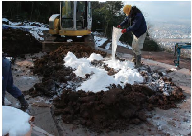
写真 136 旧盛土への酸化マグネシウム混合状況（北東から）
