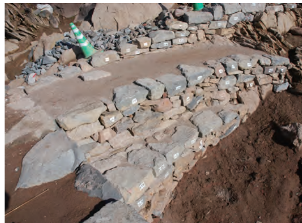
写真 160 甕城石積み完了状況②（西から）
