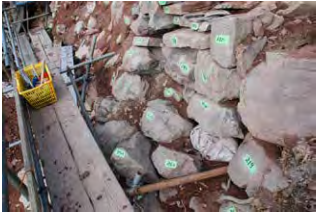
8- 2 高石垣のテラスの詳細（南から）
