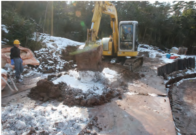
写真 137 酸化マグネシウム攪拌状況（北から）
