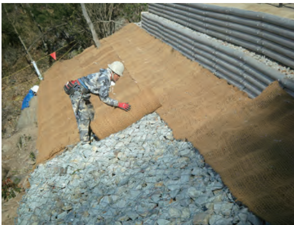
写真 177 ヤシ系マット施工状況（南から）
