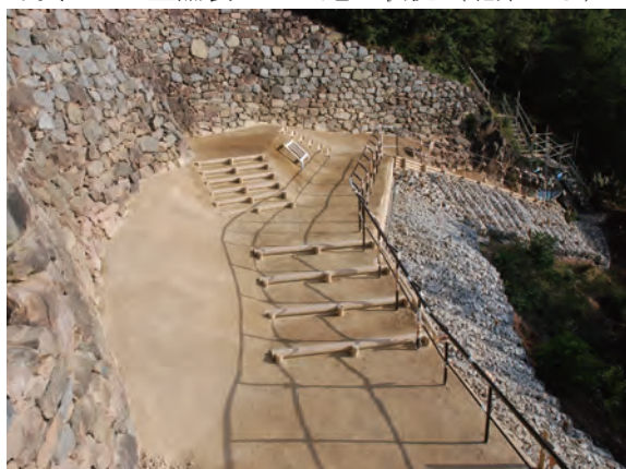
写真 184 土舗装1・2施工完了状況（北から）
