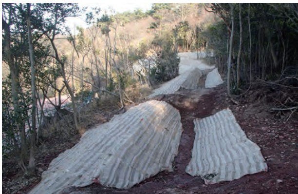
写真 215 土堤部施工状況②（南から）
