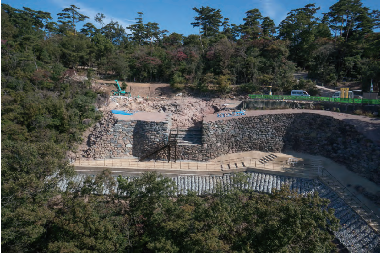
写真 186 城外側施工完了状況（西から）
