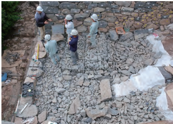
写真 123 石段設置箇所協議状況（南から）
