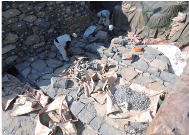
写真 125 石段設置状況②（南西から）
