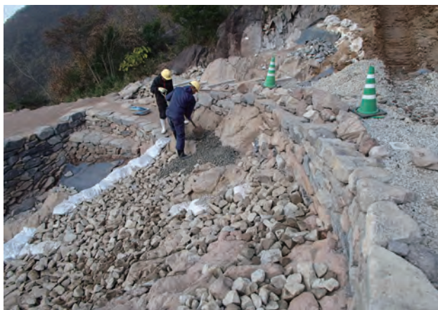
写真 163 土舗装③施工前凹地造成状況（南から）
