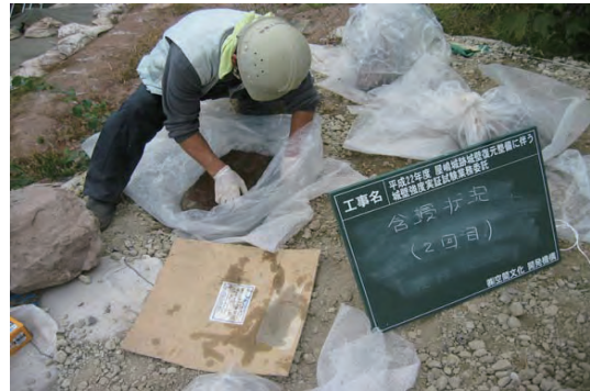
写真 40 石材薬材含浸状況②
