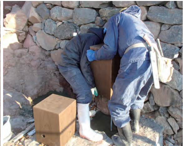
写真 210 門柱設置状況（北西から）
