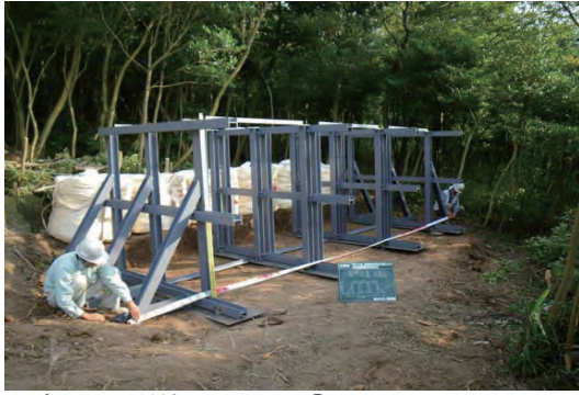
写真 35 型枠設置状況①
