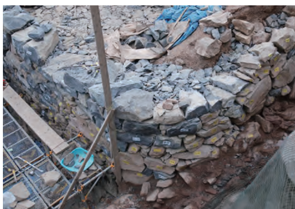
写真 100 城門奥側の曲面構造の修復状況（南から）
