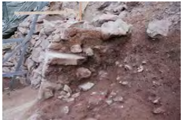
10- 6 城門南側城壁崩落部土層（南から）
