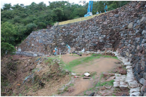
写真 171 環境整備工事着工時（南から）
