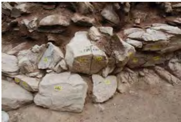
18- 1 城門北側城壁根石⑤（西から）
