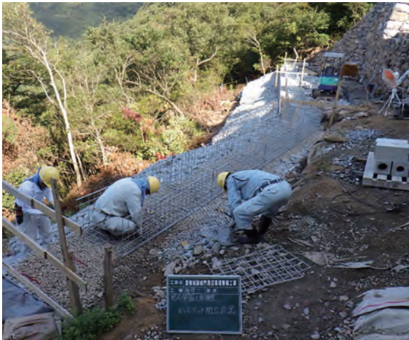
写真 173 城外側めっきかご枠設置状況（南から）
