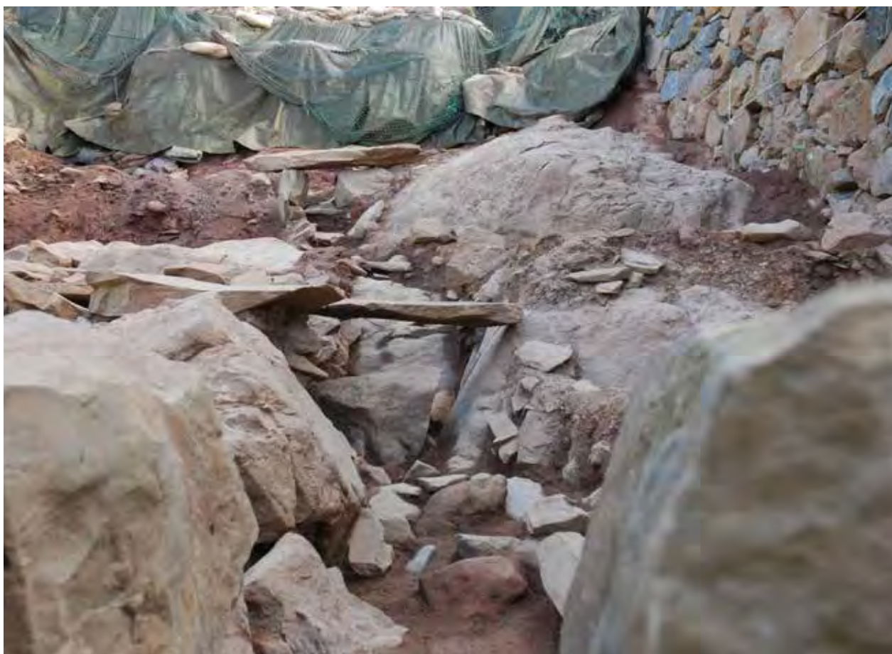
31- 2 排水溝蓋石修復状況②（西から）
