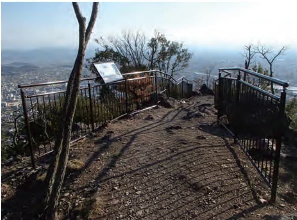
写真 189 眺望点整備完了状況（北から）
