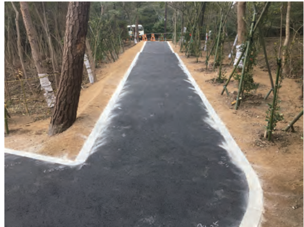
写真 220 見学路①基層舗装状況（南から）
