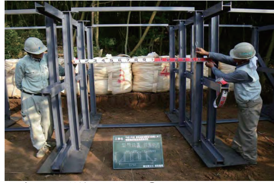
写真 36 型枠設置状況②
