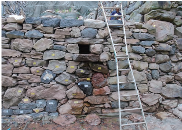
写真 121 排水溝完成状況（西から）
