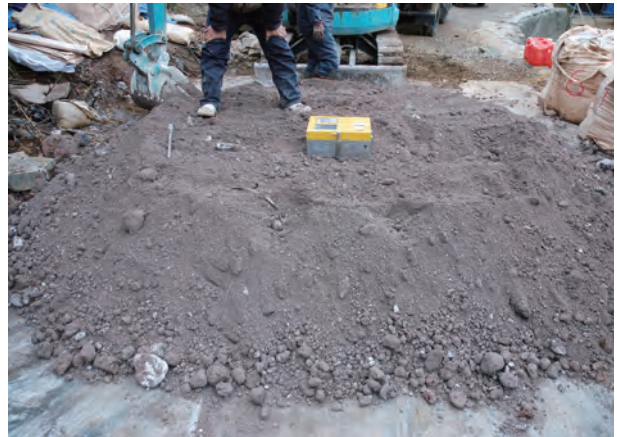
写真 138 最適含水比測定状況（北から）
