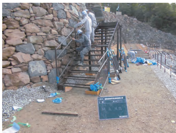
写真 181 鋼製階段設置状況（北から）
