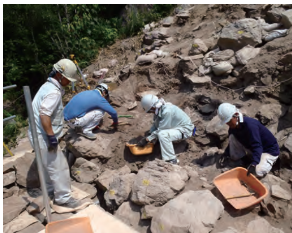
写真 81 盛土掘削状況①（南から）
