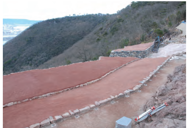
写真 206 土舗装④⑤完了状況（南東から）
