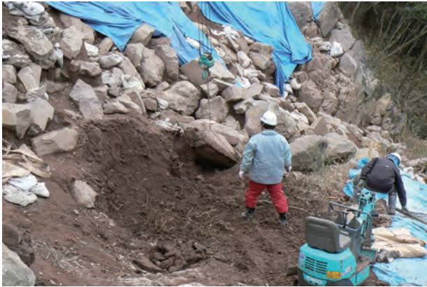
写真 74 転石回収状況②（北から）
