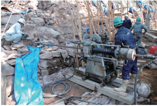
写真 151 排水補強パイプ掘削状況（北西から）
