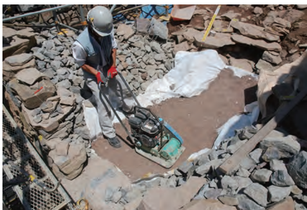
写真 113 下地設置状況（南西から）
