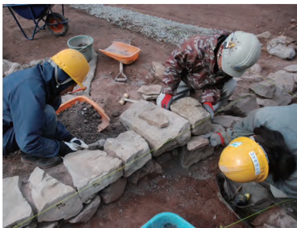
写真 101 南側城壁背面石積み状況（南東から）
