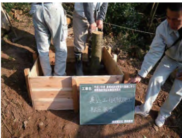
②人力つき固め状況
