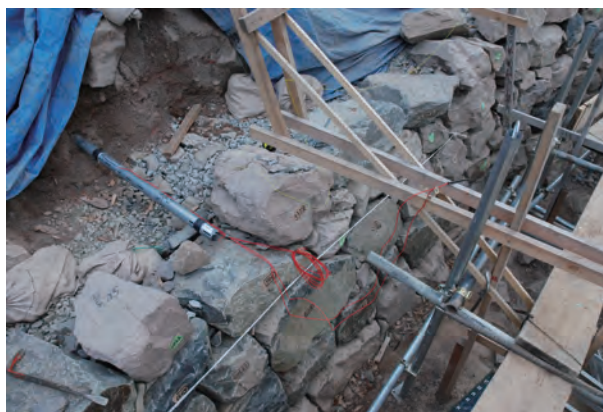
写真 232 ひずみ計設置状況②
