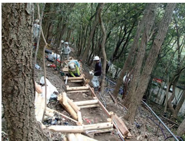
写真 227 見学路②設置状況②（北東から）
