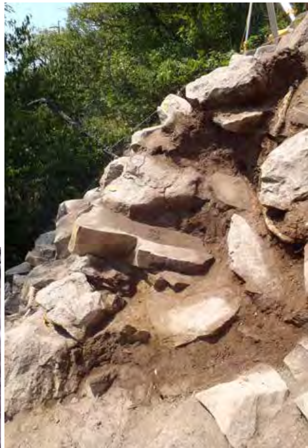
22- 5 城門北側城壁石積み背面土層③（南から）
