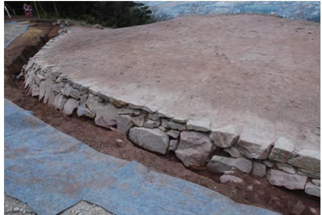
写真 104 南側城壁背面石積み完成状況②（北東から）
