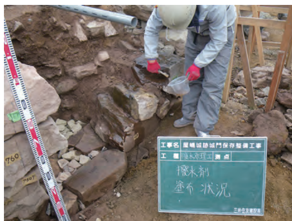
写真 144 撥水剤塗布状況 (北から)
