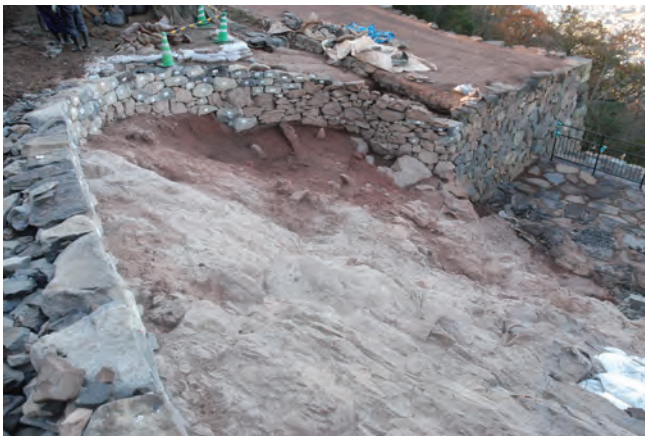
写真 161 甕城石積み完了状況③（北西から）
