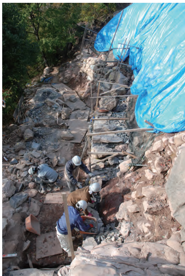
写真 99 北側城壁石積み状況①（南から）
