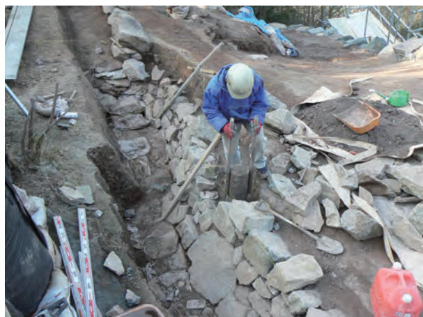
写真 102 南側城壁背面石積み背面盛土施工状況（南から）
