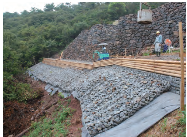
写真 176 じゃかご設置状況②（南から）
