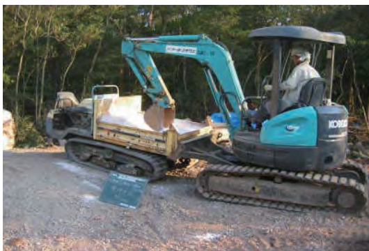
写真 51 酸化マグネシウム攪拌状況
