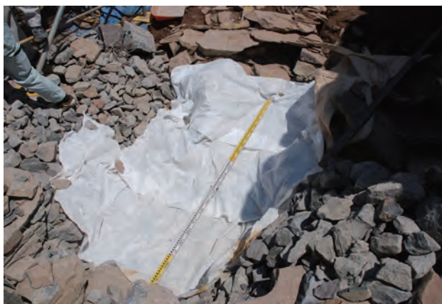
写真 112 不織布敷設状況（南西から）
