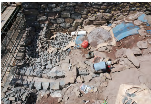
写真 116 側石設置状況①（南から）
