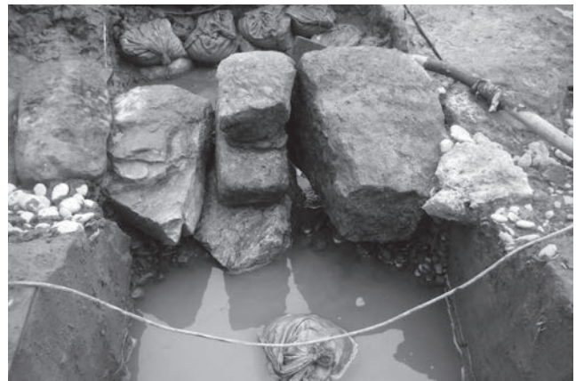
石垣背面の様子① 北から
