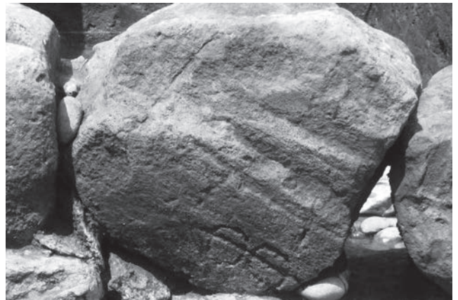
石垣刻印近影② 南西から
