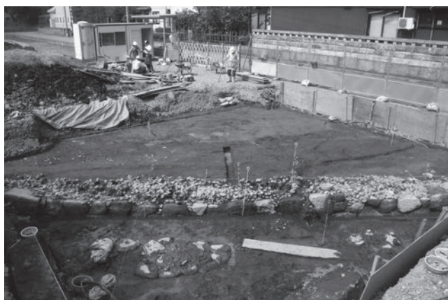
石垣検出状況 南西から
