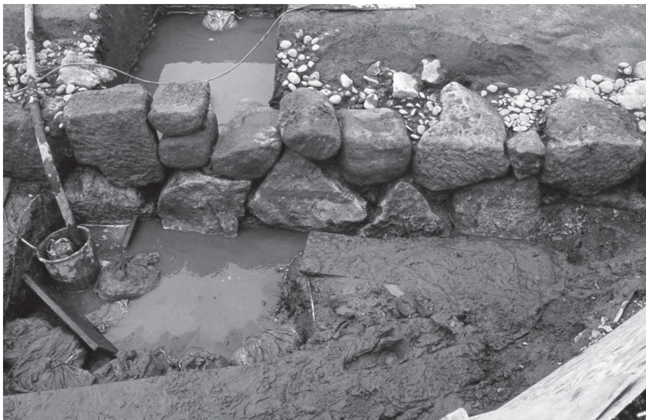
石垣近景（東側） 南から
