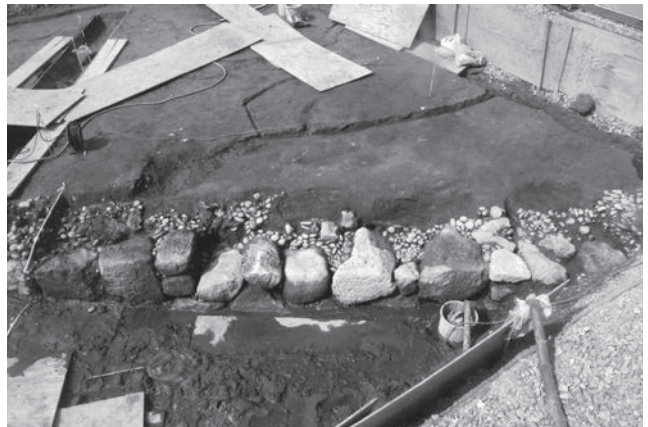
崩落ぐり石除去後 (東側) 南から
