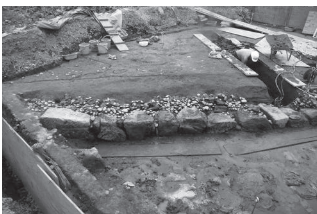
崩落ぐり石除去後(西側) 南西から
