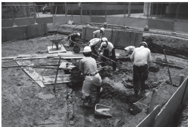
堀掘削作業 北西から
