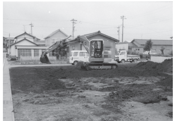
埋め戻し作業
