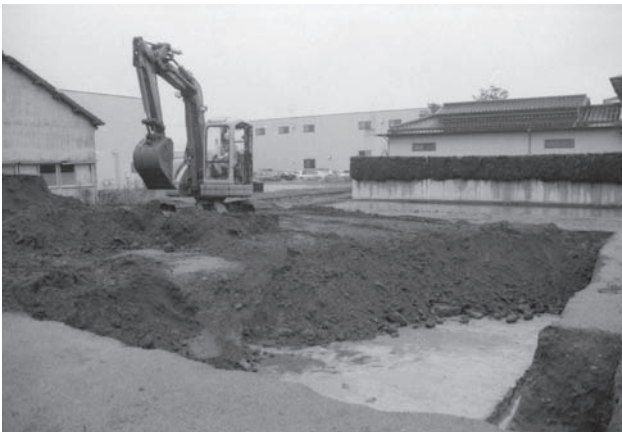
埋め戻し作業
