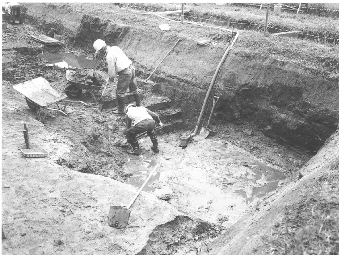
S R 2 掘削作業風景
