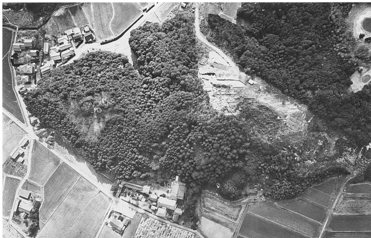
第1次調査区遠景（北から）
