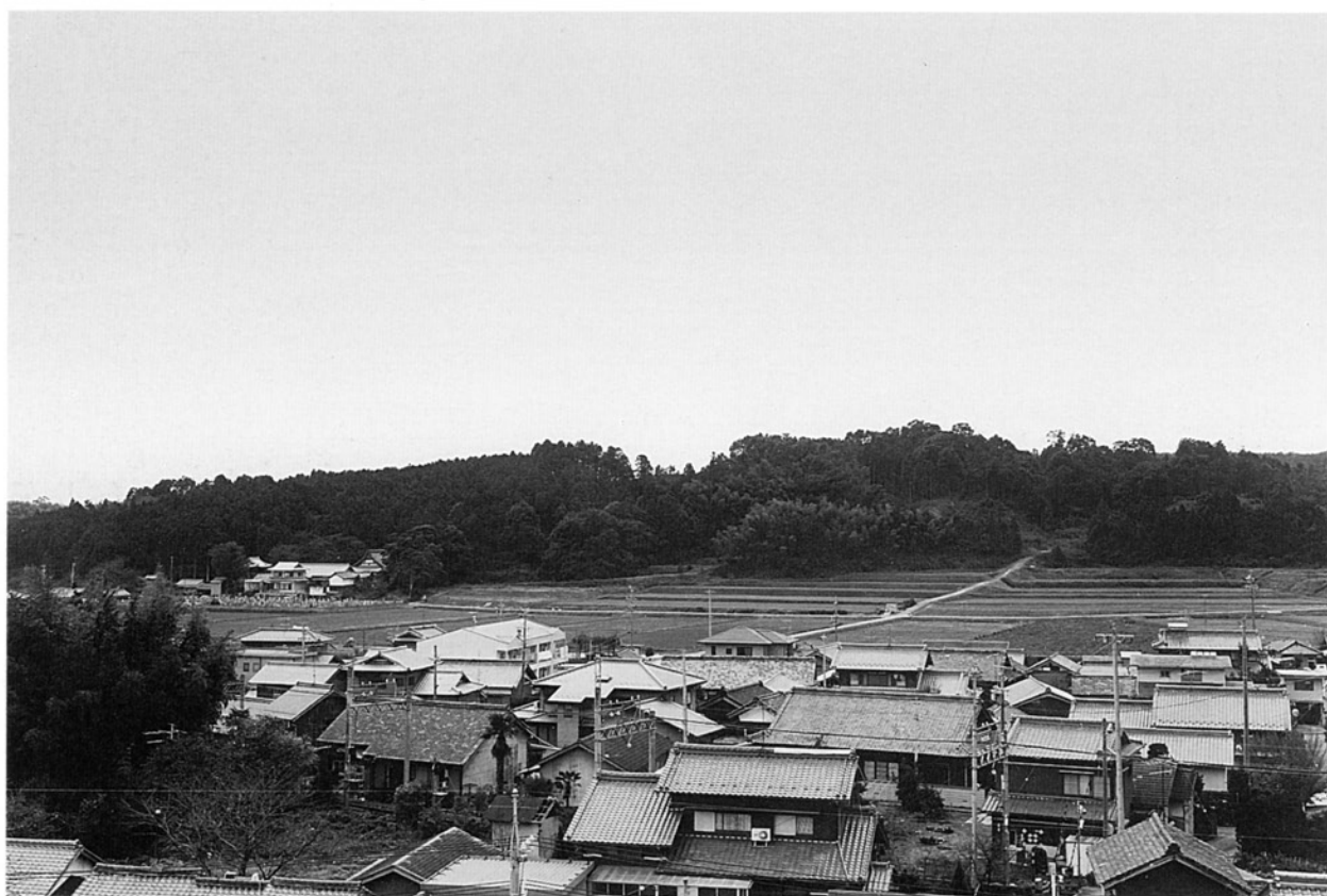
力尾城跡遠景（北から）
