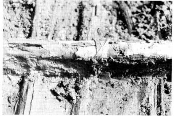
写真8 壁木舞縦材と横材の緊縛
