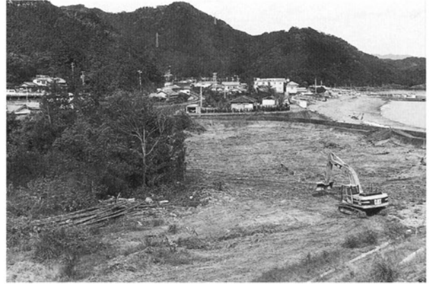
調査前風景 (南西から)
