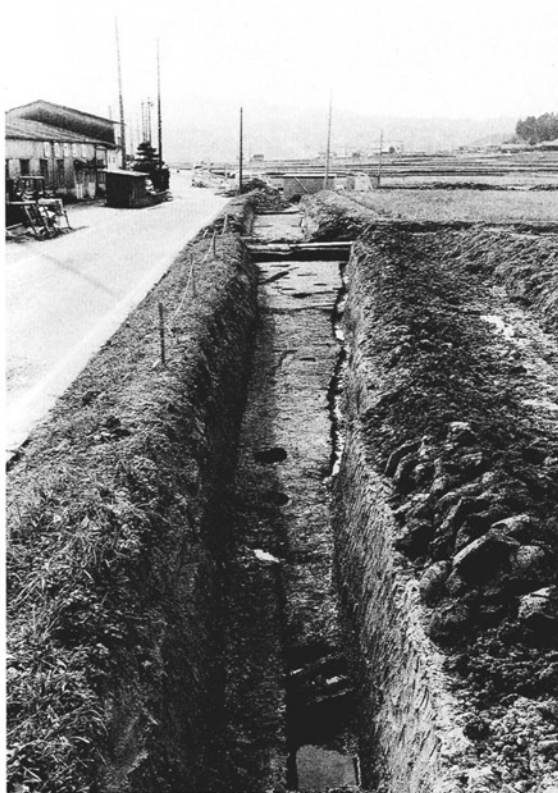
県道北部分東地区 (東より)
