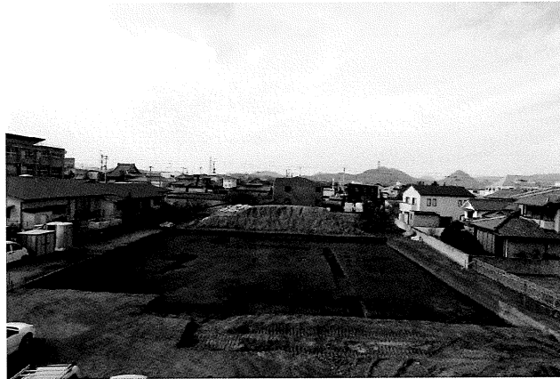
3区 第1面完掘(東から)
