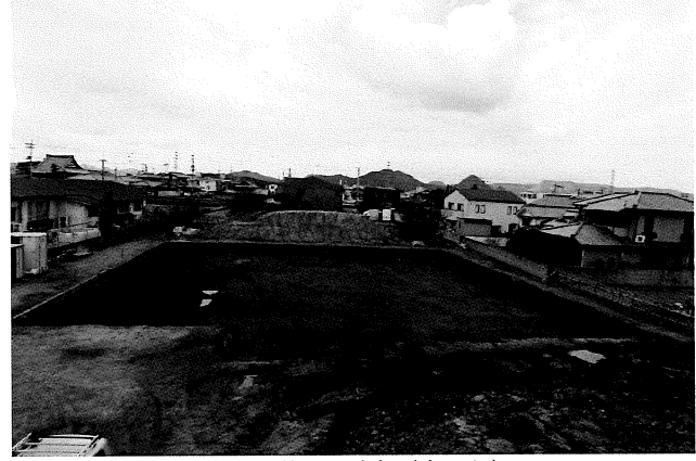
3区 第2面完掘(東から)
