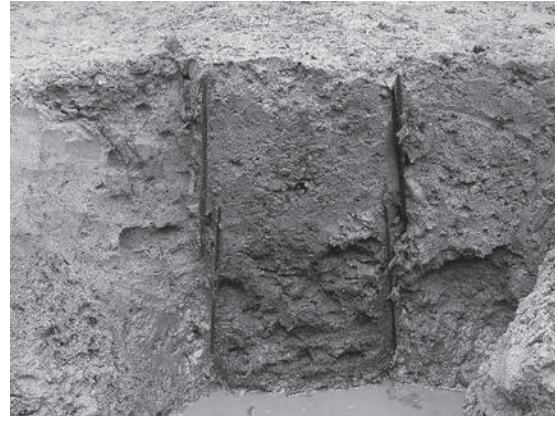
114. SE302 断面 (2) (南から)
