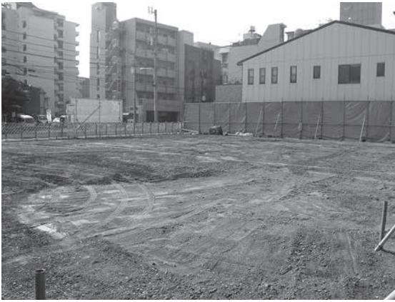
1. 調査前状況（北西から）
