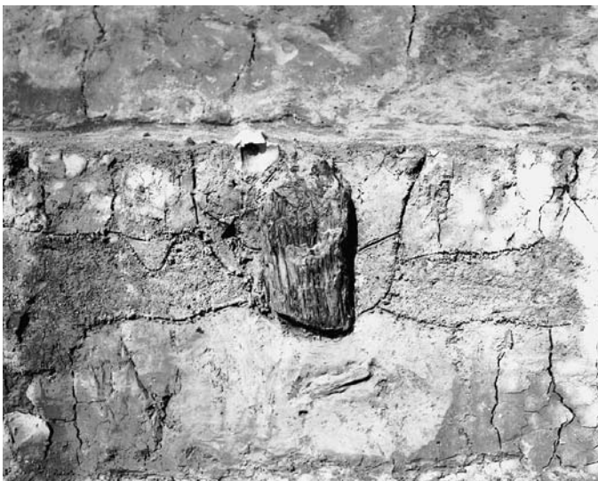
(5) SP0047 柱 (西から)
