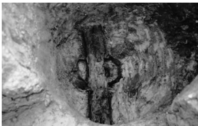
(4) SB0581 SP0258-2 (礎板)
