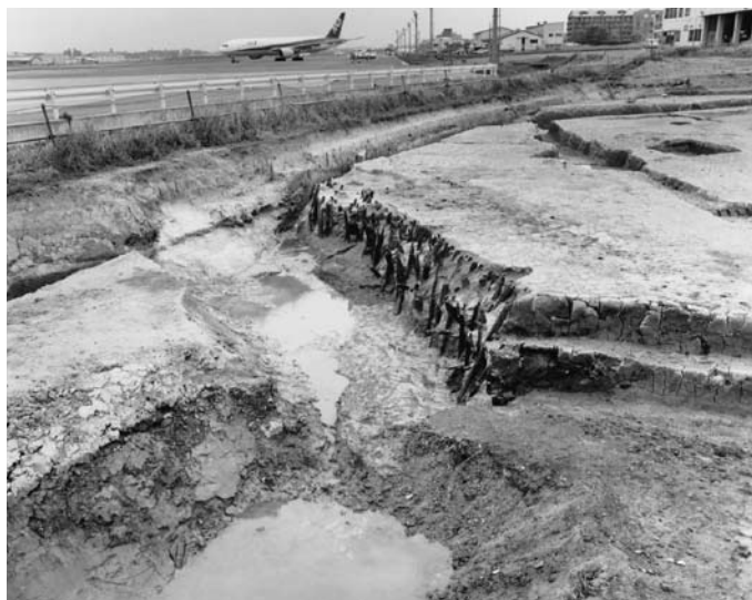
(1) SD0065 東岸杭 (3) (南東から)
