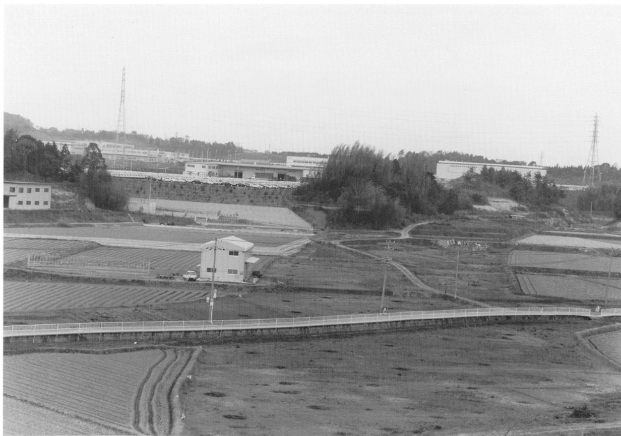
調査前風景（南から）
