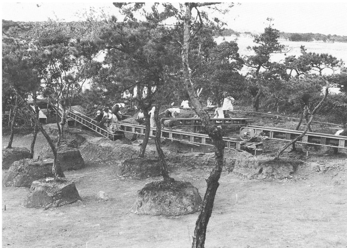
B区調査作業風景（東から）
